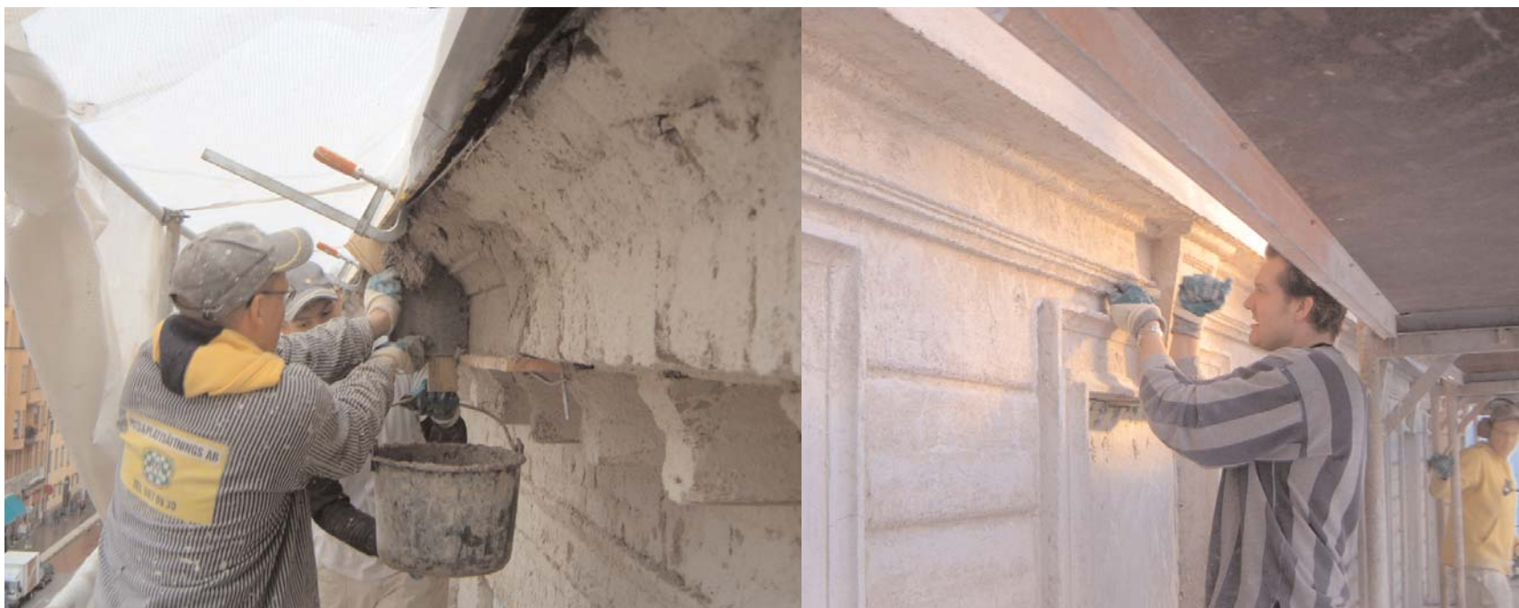
JM Fasad går i bräsch för den nya, moderna putsstekniken. Samtidigt gör de även en del jobb som innebär renoveringen av äldre fastigheter. Här syns ett renoveringsarbete på Hornsgatan i Stockholm.
