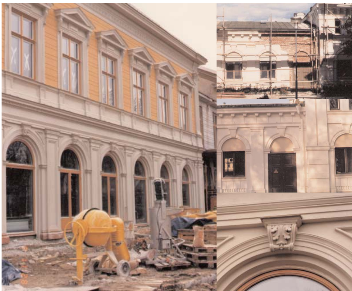
Ett av de jobb som Ronnie Jeppesen på Jeppes Puts känner sig mest stolt över är tillbyggnaden av Folkets Hus i Huddiksvall. Idag är arbetet klart, men på bilderna är renoveringen i full gång.
