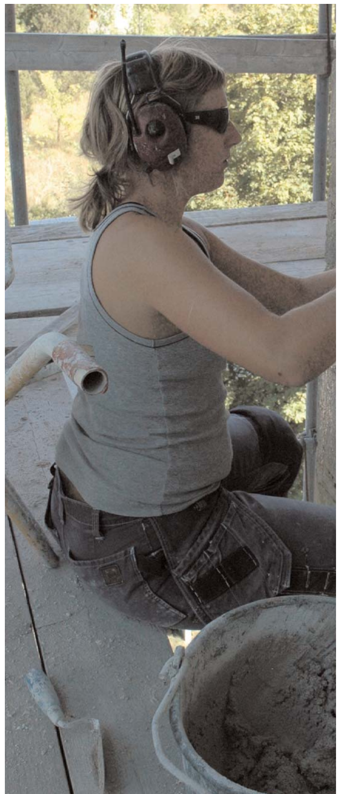
Ann-Sofie Svensson bevisar att även tjejer kan konsten att slå på kalkbruk med hjälp av kakelsleven. Hon är praktikant på Byggnadshyttan, efter att ha gått en utbildning i Byggnadsvård vid Högskolan på Gotland.
