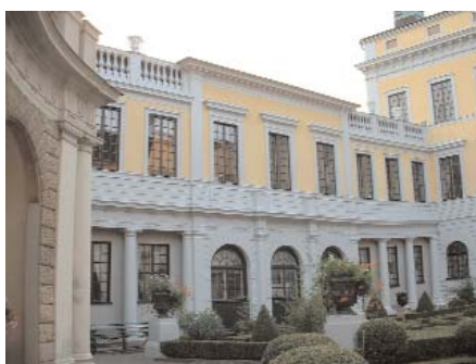
Ovan: Villa Lusthusporten uppfördes 1873–1877 efter ritningar av Axel och Hjalmar Kumlien. Fasaderna på Villa Lusthusporten nerbilades och sedan gjordes ny treskiktsbehandling med lufthårdnande kalkbruk samt traditionell kalk-avfärgning med Gotlandskalk.
