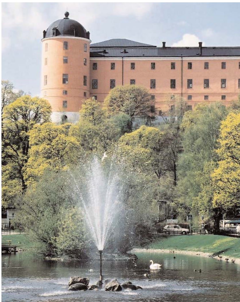
Renoveringen av Uppsala Slott är det roligaste, men samtidigt svåraste, jobb som Urban Eriksson har gjort.
