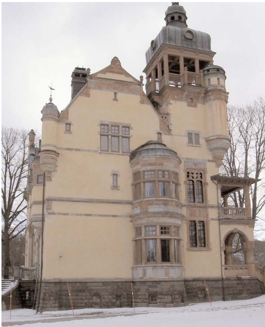
Ovan: Villa Lusthusporten uppfördes 1873–1877 efter ritningar av Axel och Hjalmar Kumlien. Fasaderna på Villa Lusthusporten nerbilades och sedan gjordes ny treskiktsbehandling med lufthårdnande kalkbruk samt traditionell kalk-avfärgning med Gotlandskalk.
