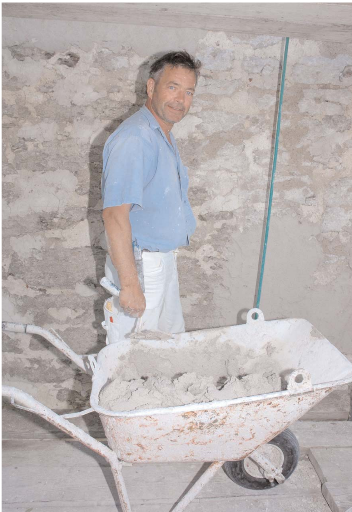
Restaureringen av kyrkfasader sker i olika steg. Här ska Thomas Johansson just sätta igång med ytstockningen av väggen.
