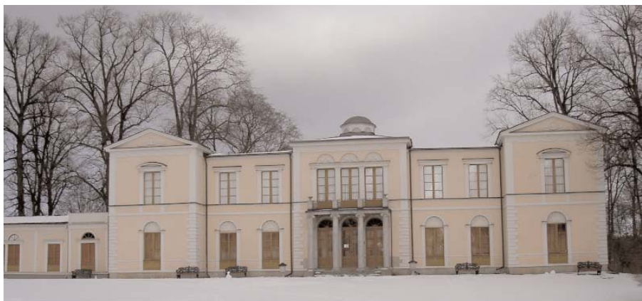
Rosendals Slott på Djurgården är ett av de kungliga slotten. Tremans Fasad AB högtryckstvättade bland annat de flesta putsytorna, avlägsnade plastfärg och avfärgade andra ytor med fabriks-tillverkad kalkfärg som pigmenterades på plats.
