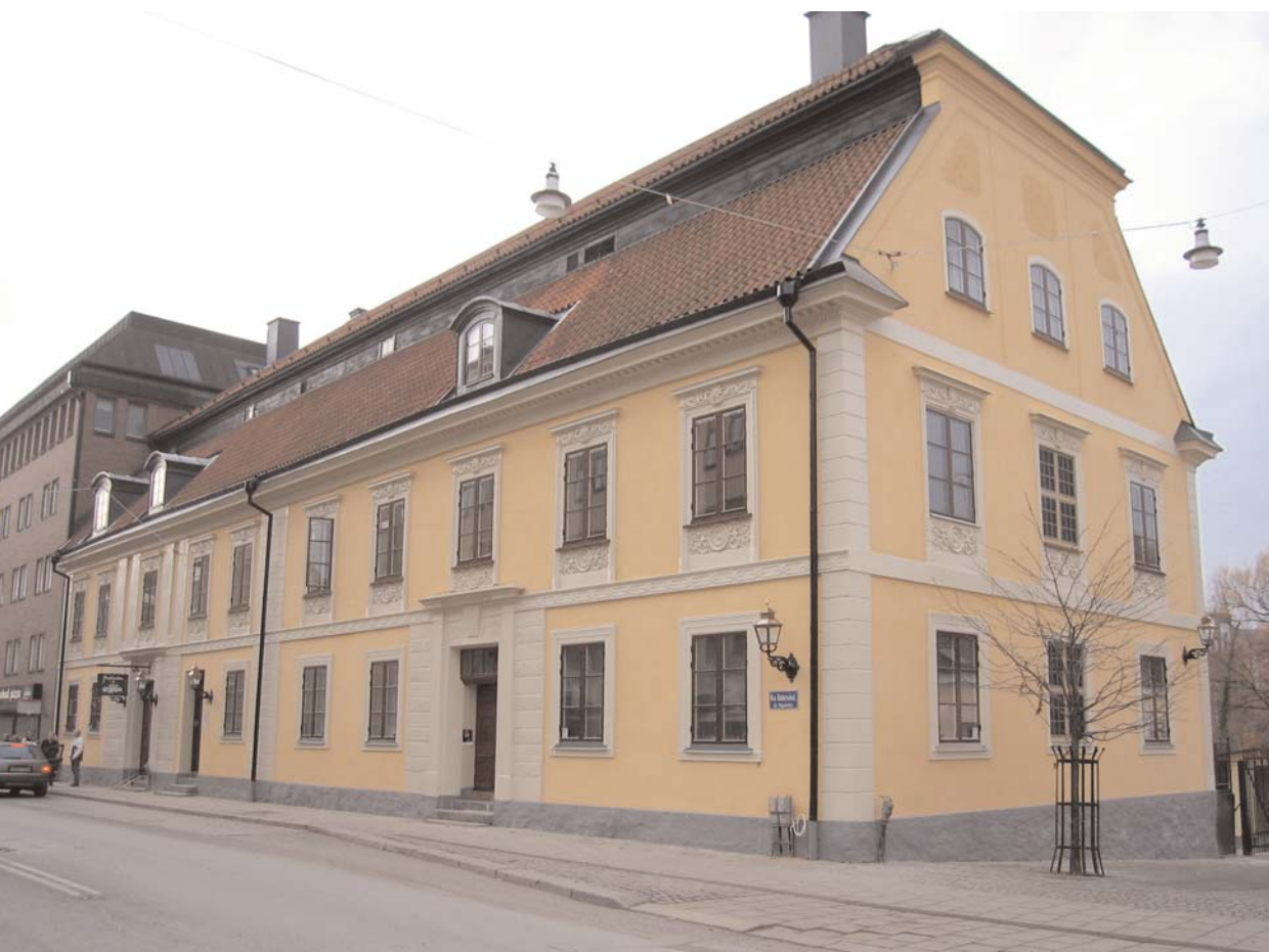
Kvarteret Vågskålen i Norrköping är ett av alla projekt som Åby Fasad har arbetat med.
