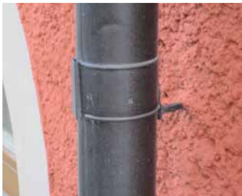
Traditionell infästning murverk
