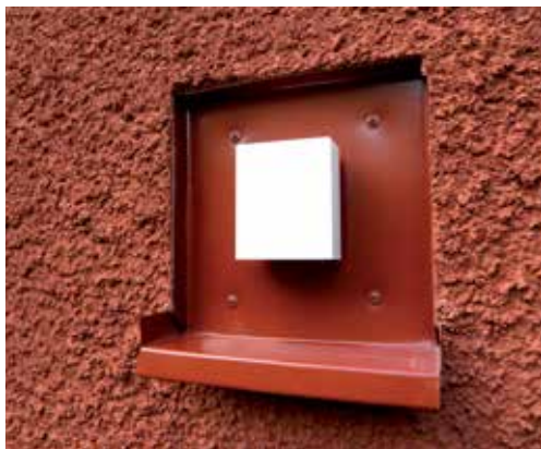
Skyddsbeslag vid givare
