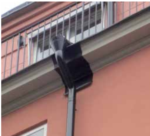
Plåttak med fotränna och skyddsbeslag bakom vattenkupa
