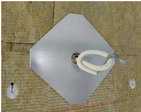
Infästningsplåt för lättare armatur med vägggenomföring
