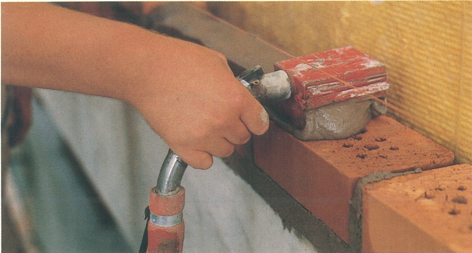
En nybörjares spritsning av murbruk. Obs, att form o mängd kan justeras efter behov.
