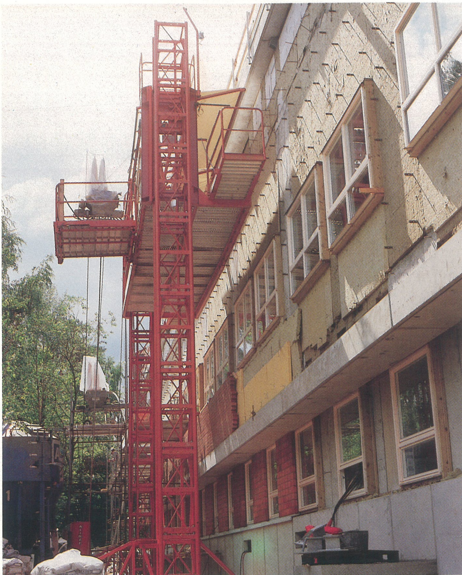
Scando WP. På väg mot de högre höjderna med utfällda gång- och makrallbryggor.
