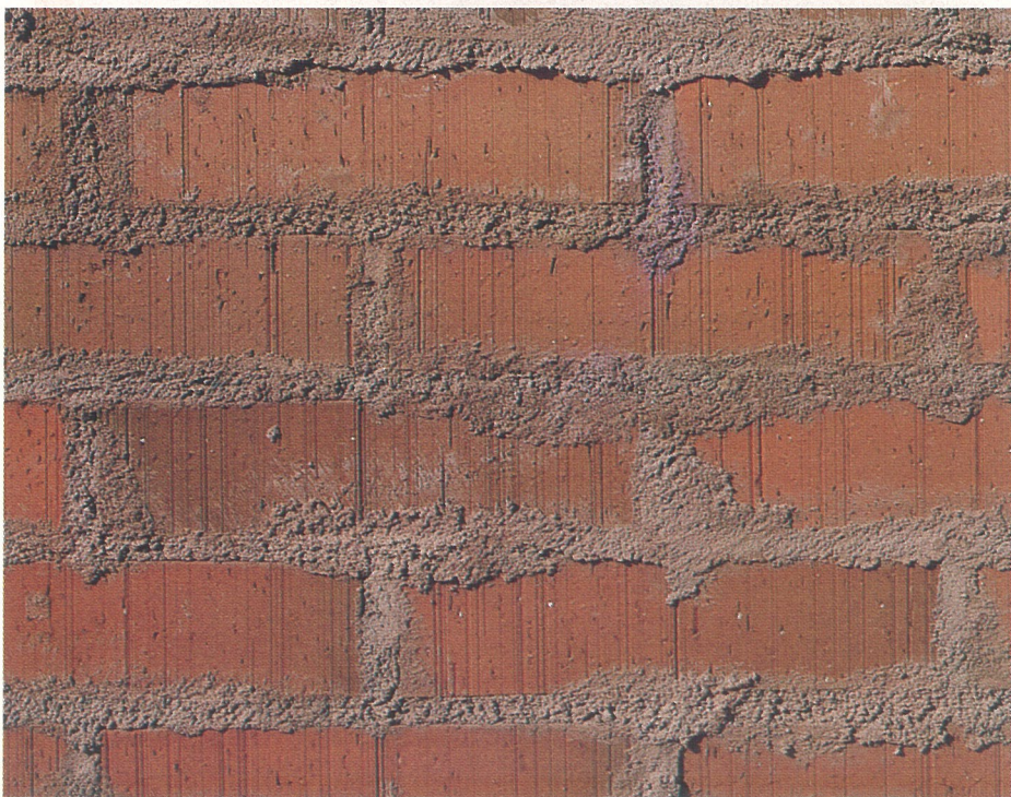
Detalj av murningsarbetet exteriört.
