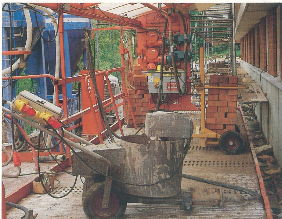
Demonstrationsuppställning av murbrukspump. Och tegelkärra med hög o sänkbara lyftgafflar.
