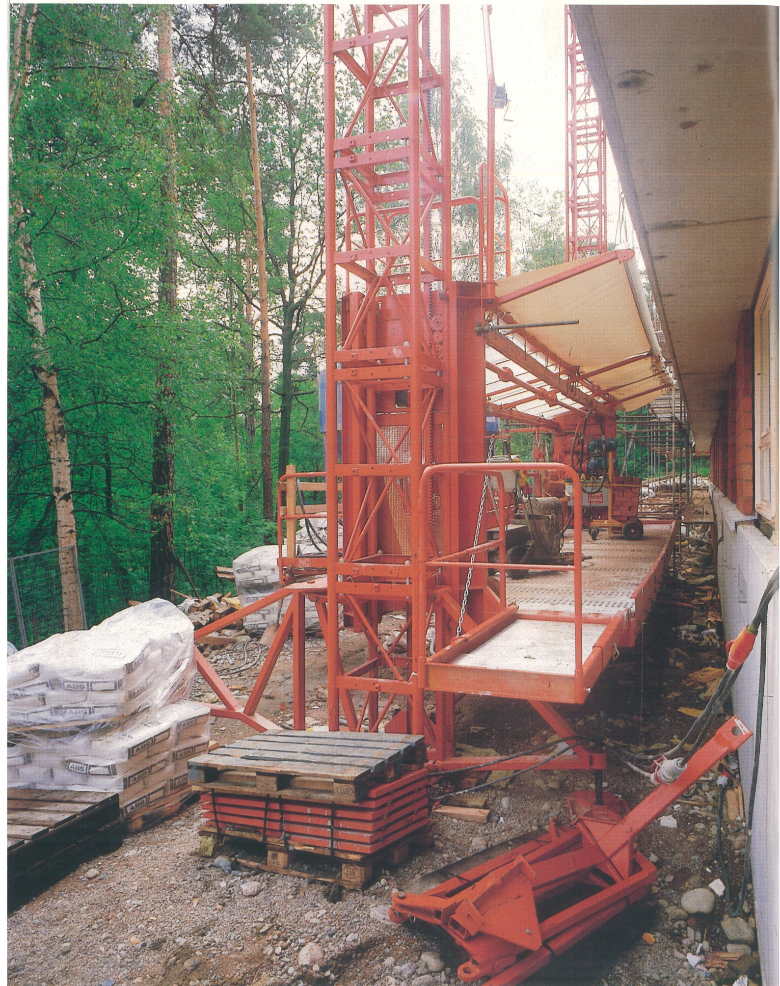
13 m lång arbetsplattform som kan ändras efter fasadens form.
