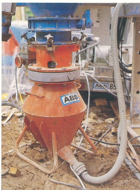
Sändare för transport av torrbruk från silon till ställning.
