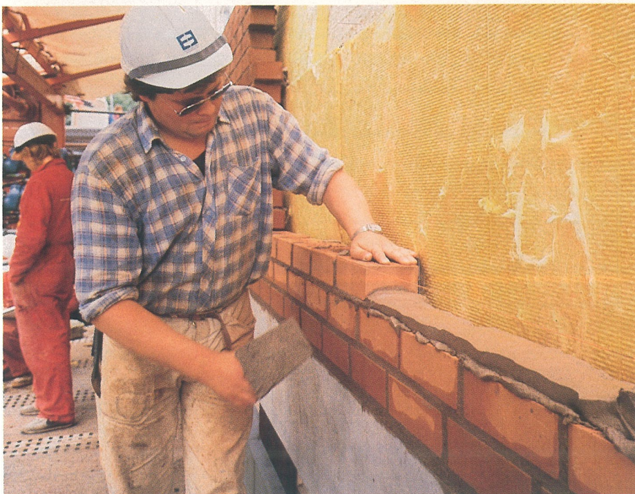
Läggning av sten i spritsad fog.
