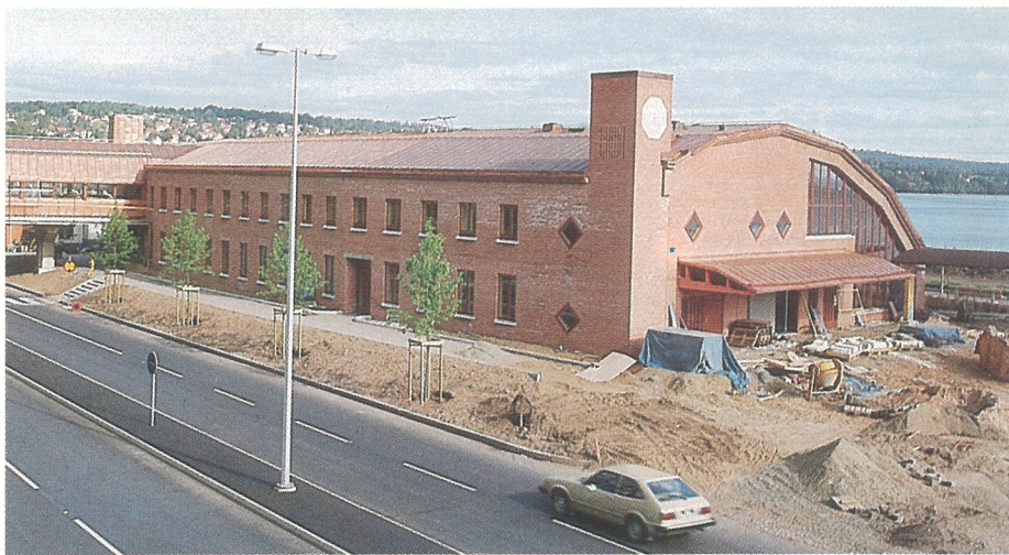
Den nya stationen ligger alldeles vid Vätterns strand, förbunden med centrum genom en täckt gångbro över en hårt trafikerad trafikled. "Det röda teglet är inspirerat av hus jag minns från de gamla fabrikena längs Vättern", berättar Carl Nyrén.
