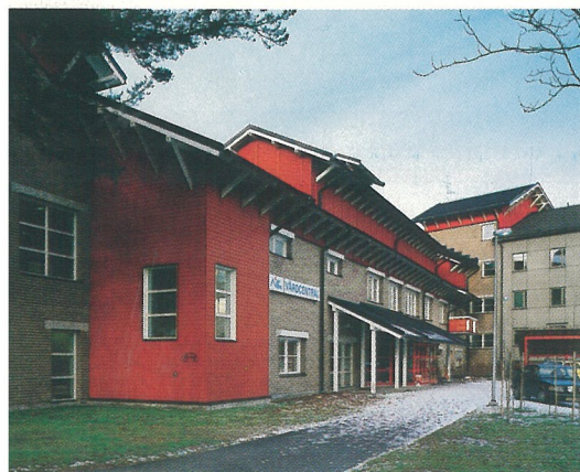
Entrésidan med anslutningen till den gamla delen av vårdcentralen.
