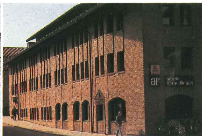
Länsarbetsnämnden i Falun. Jack Hanson Arkitektkontor. Tegel: Haga brunett.
