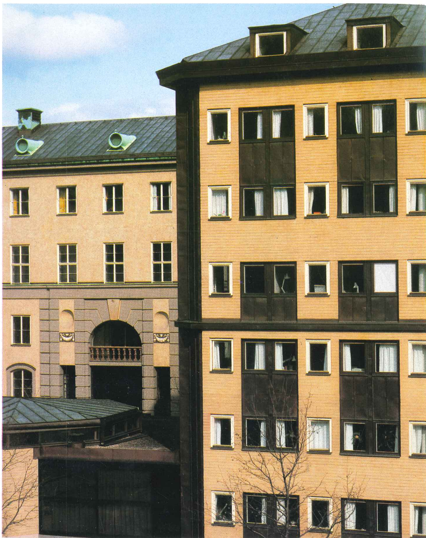
Tillbyggnad av Handelshögskolan. Åke Ahlström Arkitektkontor AB, Stockholm. Slammat modultegel. För att betona den nya fasaden är de horisontella fogarna ritsade.
