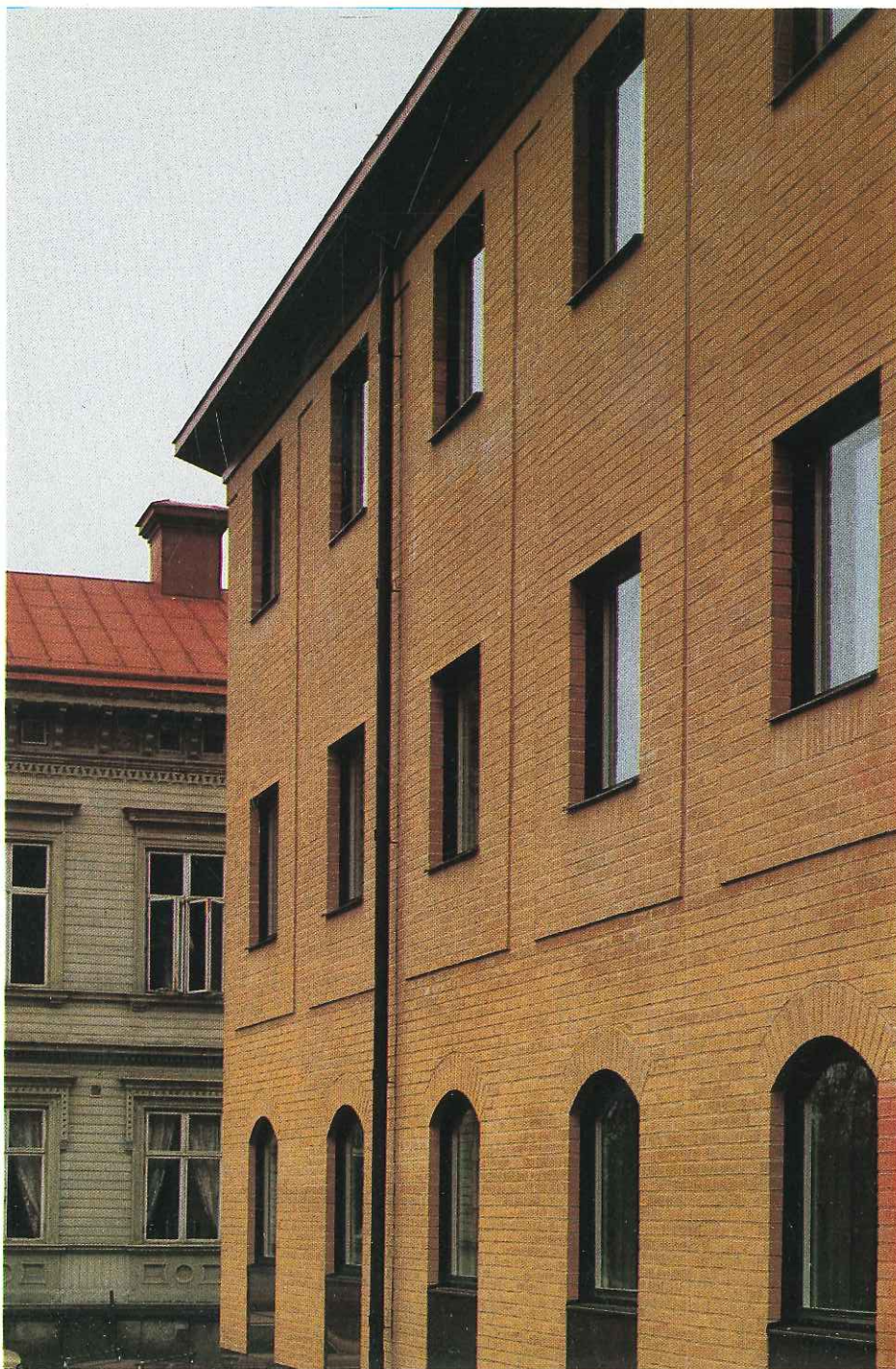
Förvaltningshuset i Söderhamn. Jack Hanson Arkitektkontor, Söderhamn. Trädsuret tegel från Östra Grevie, terrakotta.
