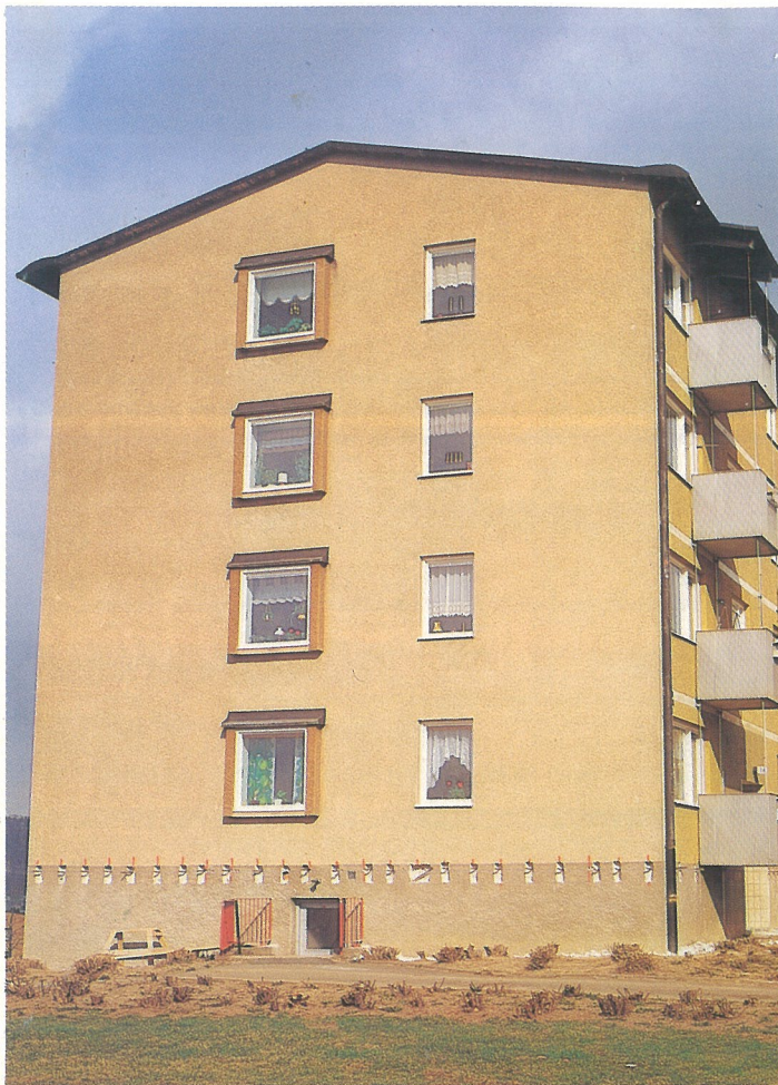
Upplagsbalkens förankringsjärn är på plats.
