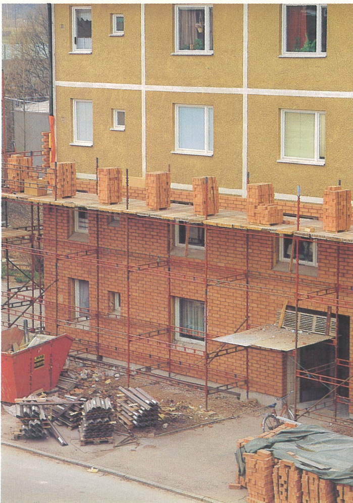
Rationell murning med modultegel.
