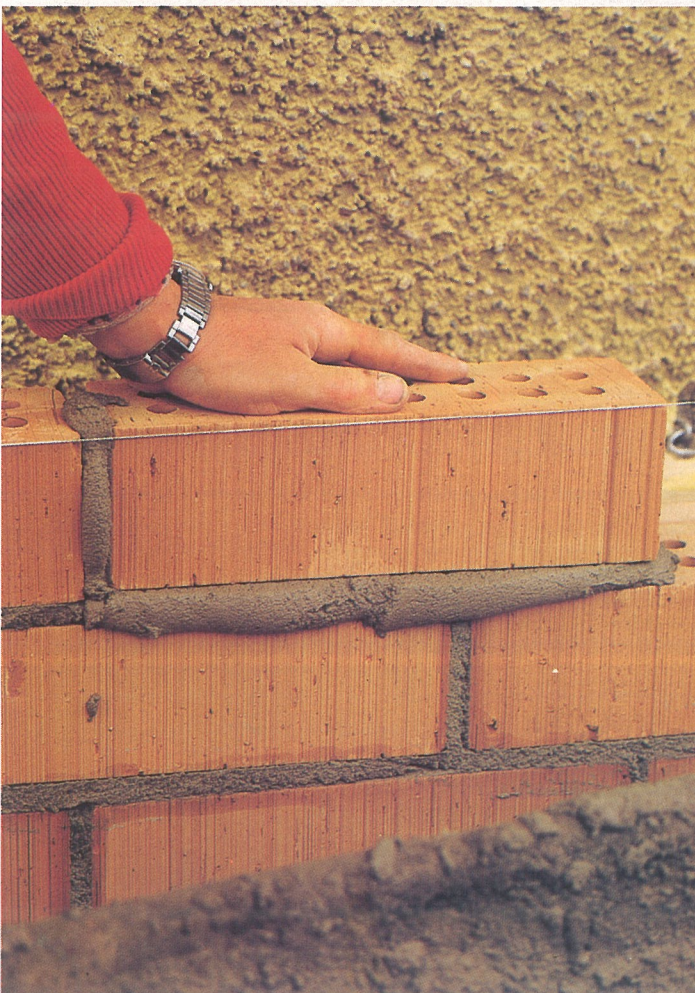
Det går åt mindre bruk med modulsten.
