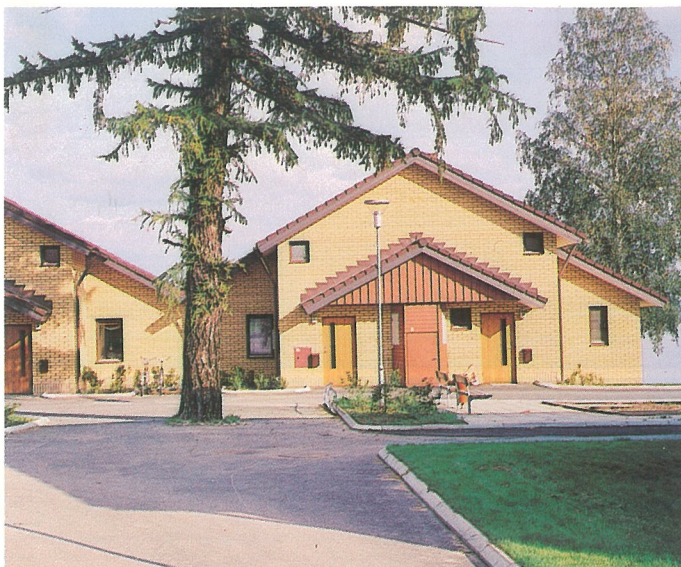
Östra Främby, Falun. Utfackningsväggar med träregelstomme. Bärande stomme av betong. Tegel på fasaderna. Jack Hansson Arkitektkontor i Falun. Byggherre: HSB.
