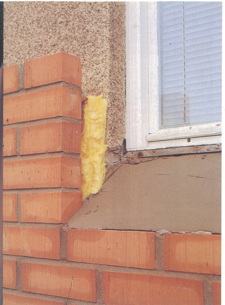
Fönstersmyg före plåtbeslagning.
