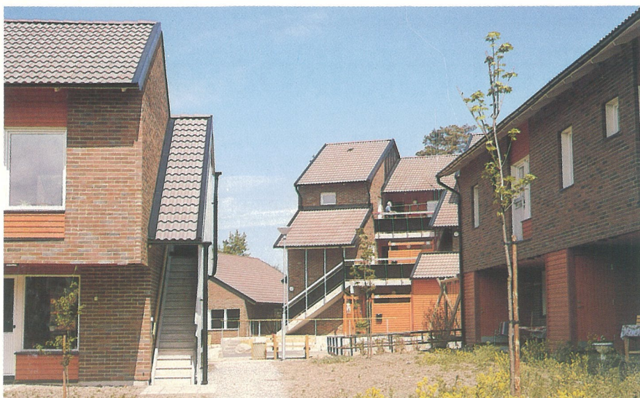
Vallatorp, Täby. Flerfamiljshus med utfackningsväggar av trä. Fasadtegel. Höjer-Ljungqvist Arkitektkontor, Vällingby.
