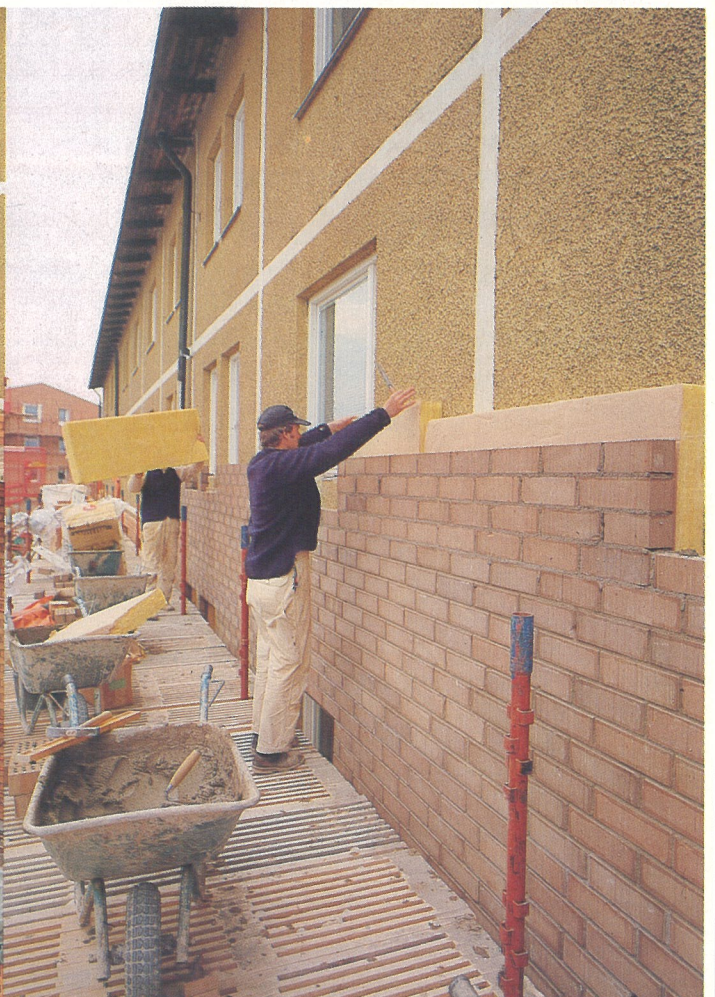
Isoleringen ligger momentet före murningen.
