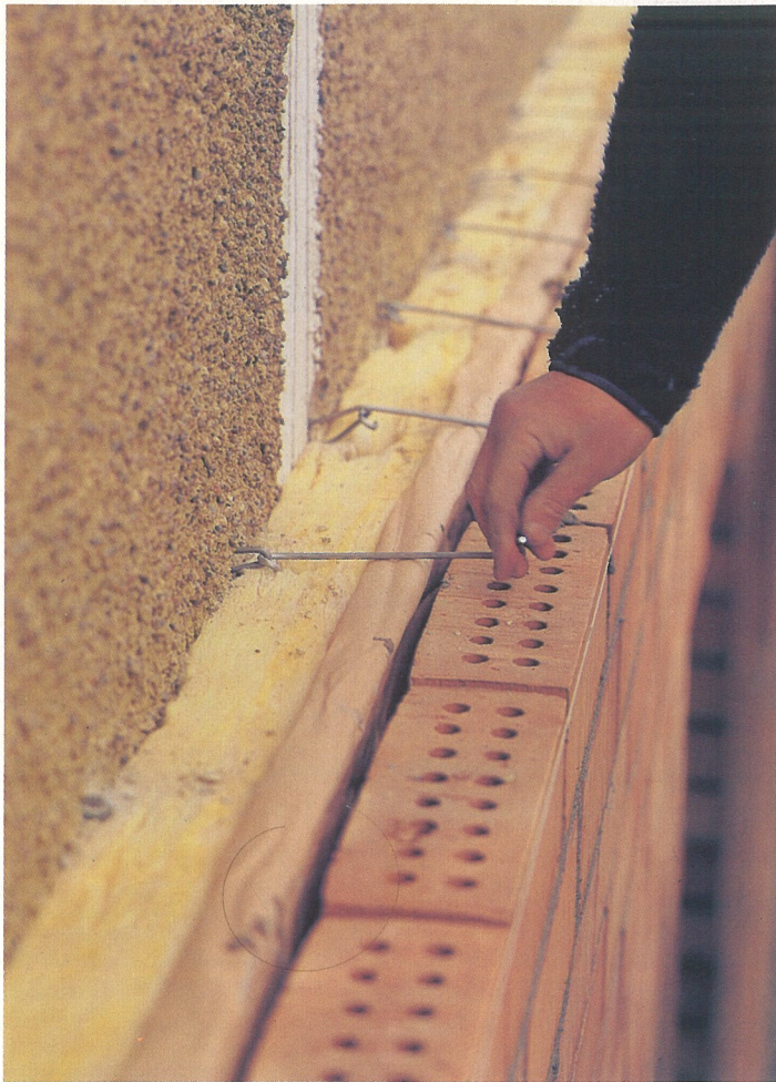
Montering av ledade kramlor.
