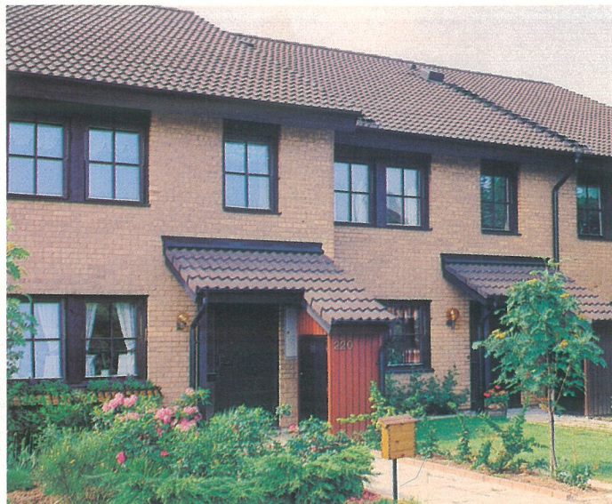
Kv. Roxen 16, Malmö. Träregel/fasadtegel. L-E Magnussons Arkitektkontor AB, Helsingborg. Byggherre och entreprenör: Kullenbergbyggen Malmö AB.
