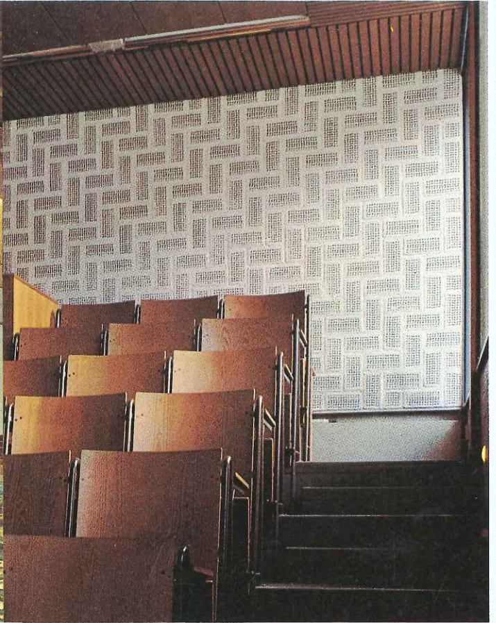
Hörsal i A-huset vid Chalmers Tekniska Högskola, Göteborg. Bakväggen är byggd med akustiktegel, som vit-slammat. Målningen förändrar inte väggens absorptions-egenskaper.
