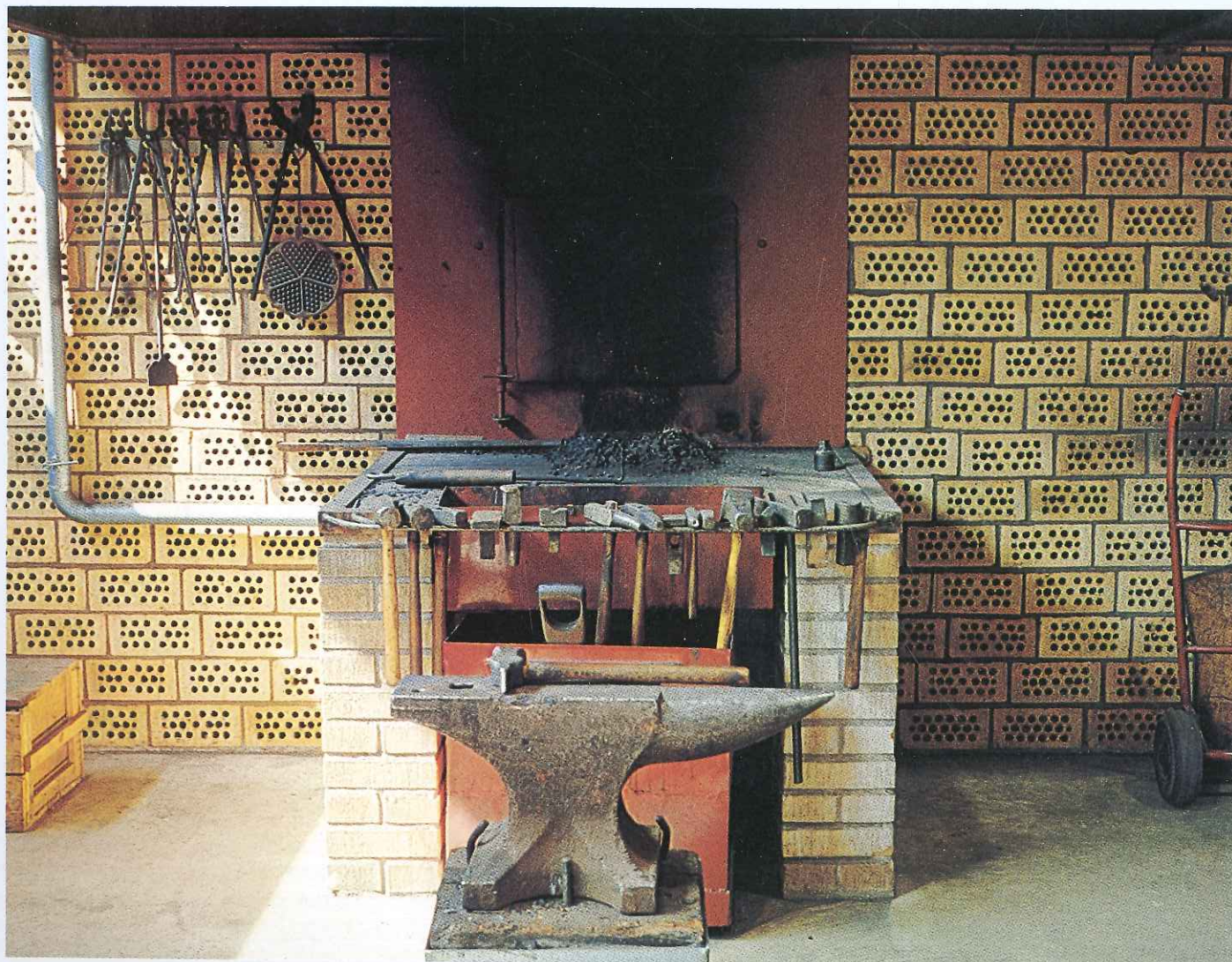
Ru-19-tegelväggar i anläggningen för försäljning och service hos Skånska Lantmännens Maskin AB i Ängelholm.
