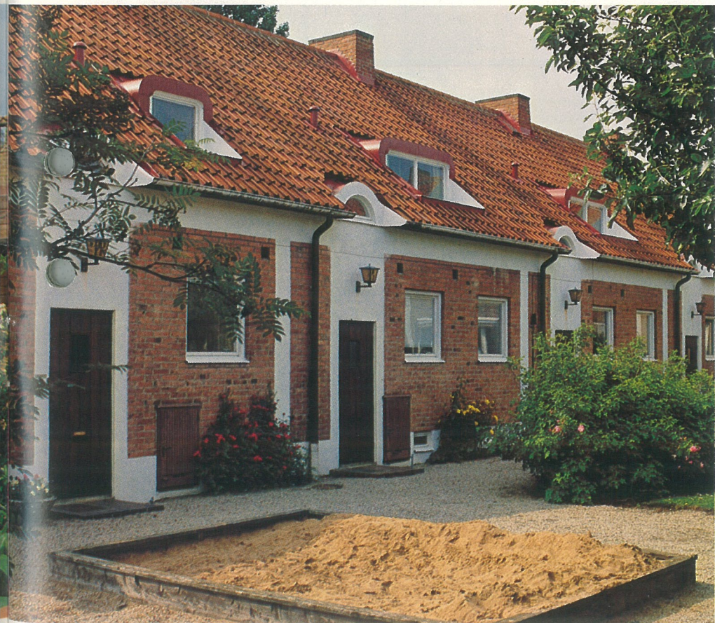
Linnéstaden vid Pedellgatan i Lund uppfördes av byggmästare Harry Karlsson i slutet av fyrtiotalet. Arkitekten var Hans Westman. Bärande tegelstomme och yttreväggar av rött tegel med inslag av putsade fasaddetaljer.
