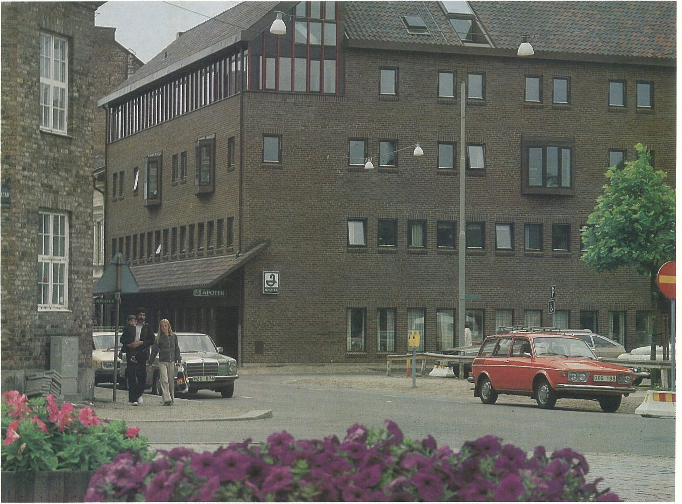
Affärshus, kv Hertig Knut, Halmstad, murat med Bohus Konstfasad Special
