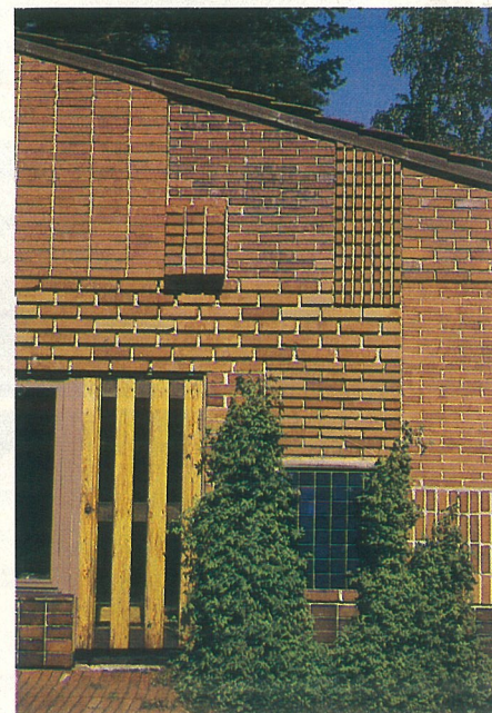
Experimenthus, Muuratsalo, 1952–53. På sitt sätt en höjdpunkt i Alvar Aaltos kraftfulla tegelbyggnadsserie utgör hans egen fritidsbostad, där han prövat olika tegelkvaliteter och murningsmetoder.
