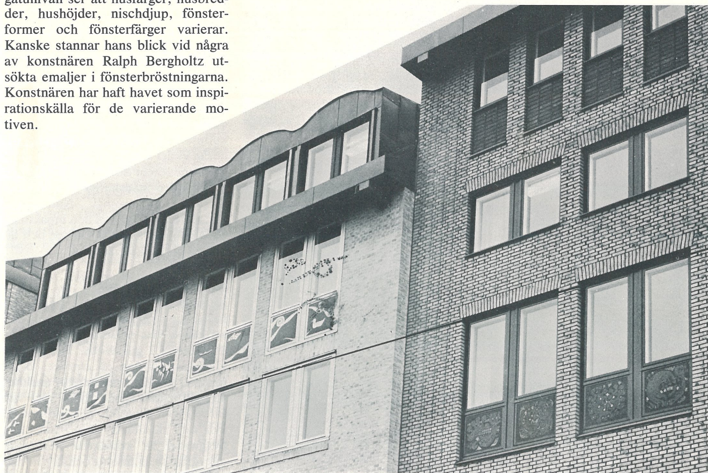
Den flanör som lyfter blicken över gatunivån ser att husfärger, husbredder, hushöjder, nischdjup, fönsterformer och fönsterfärger varierar. Kanske stannar hans blick vid några av konstnären Ralph Bergholtz utsökta emaljer i fönsterbröstningarna med varierande motiv från havet.
