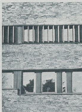
Fig. 1.12 Aust-Agder Sentralsjukehus. Fasadensnitt Behandlingsfløy. Foto: R. Tveteraas.
