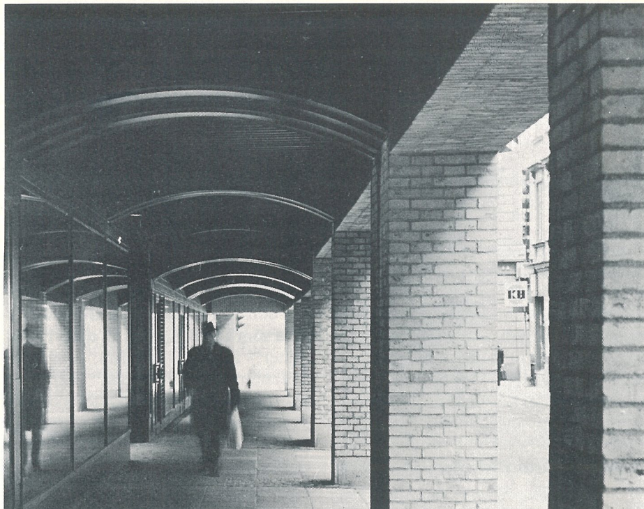
Mot gatan "skyddar" rejäla tegelpelare och valvbågar ger känslan av att man går in under något som vilar ovanpå.
