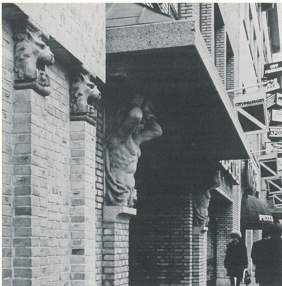
I räckhöjd finns lejonhuvuden och atlaner från den tidigare byggnaden på platsen. De bär symboliskt upp, precis som då, vissa fasaddelar och entréer.
