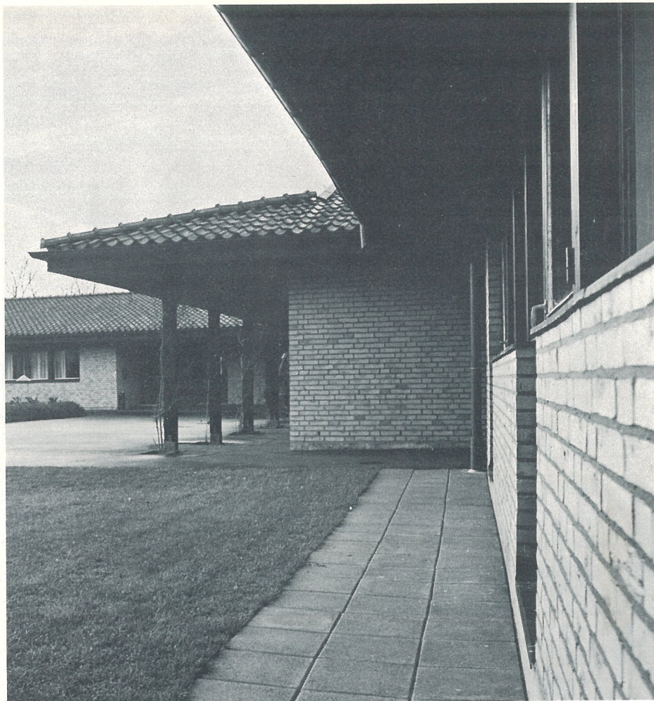
Gymnastik- och verkstadslängan. I bakgrunden del av administrationsbyggnaden.
