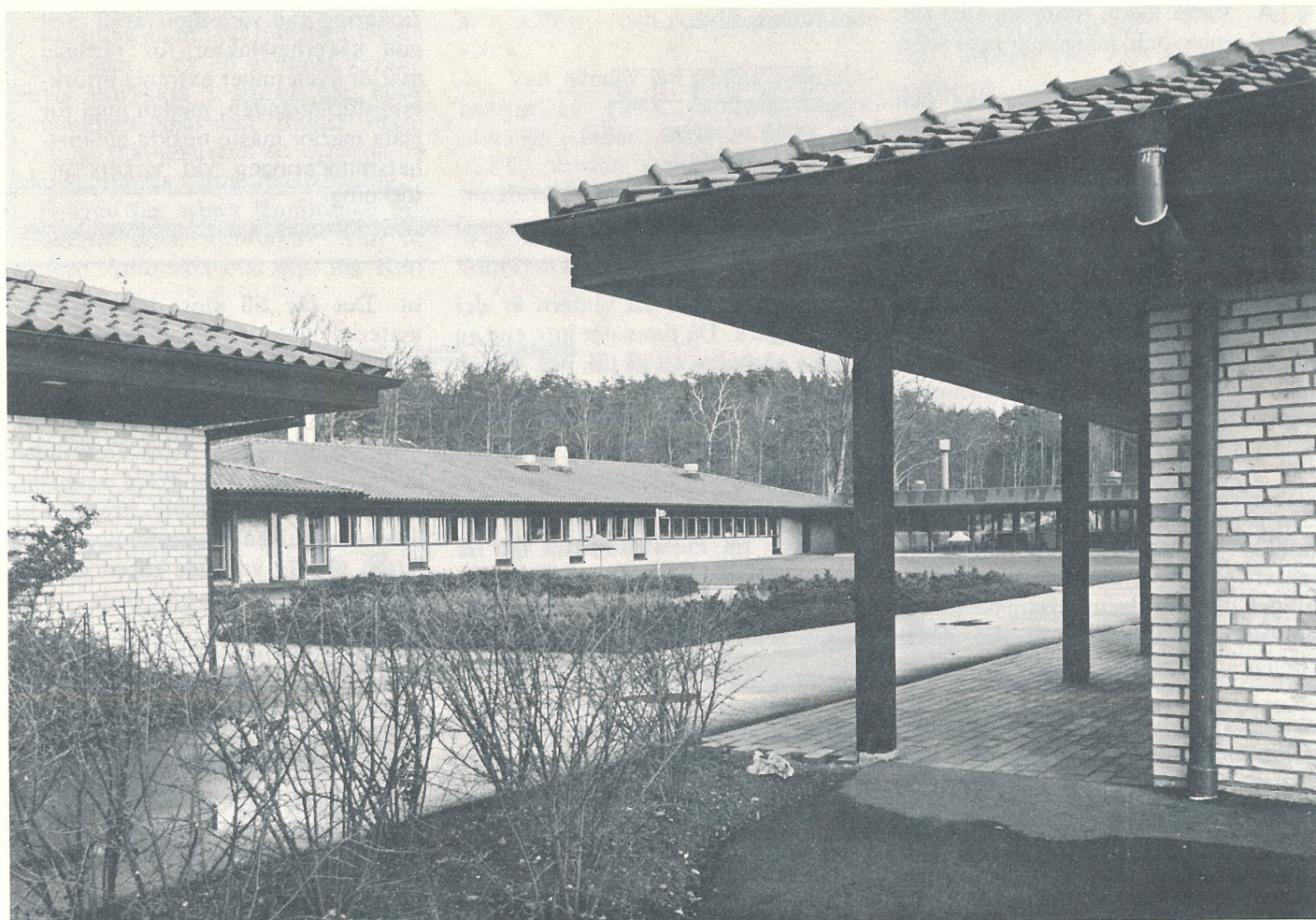
Verkstadslängan och simhallen. Del av administrationsbyggnaden närmast t.v. samt entré till ett av elevhemmen t.h.
