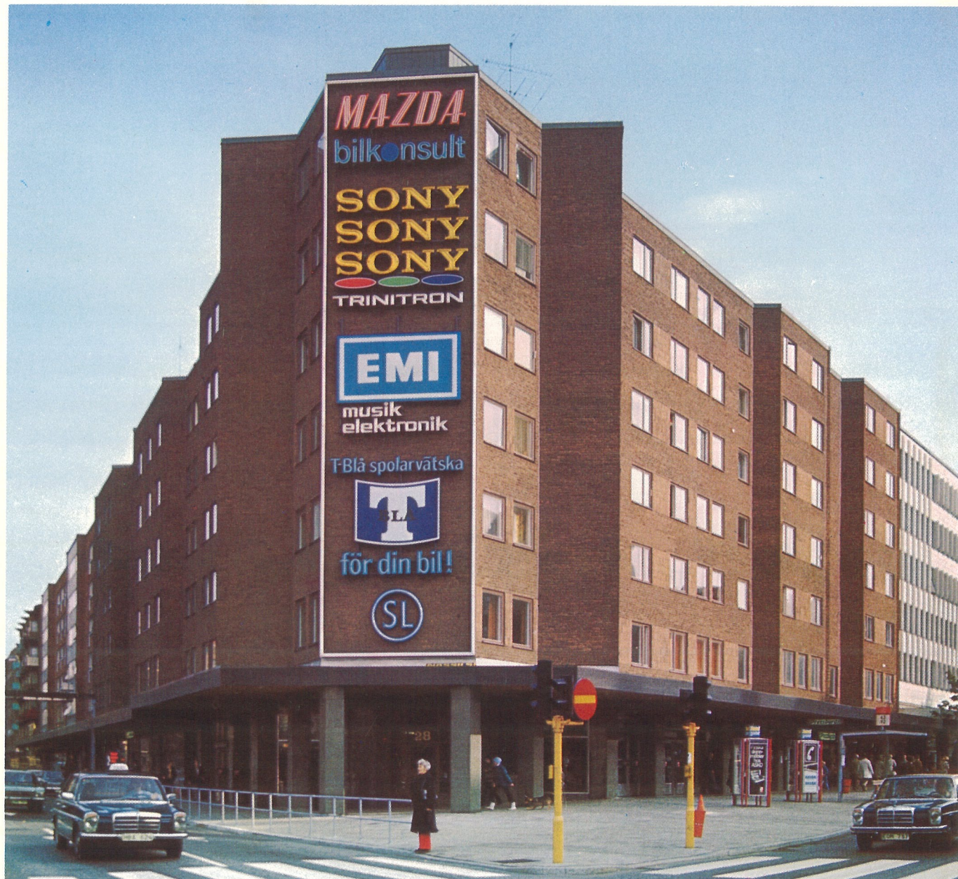
Nyuppfört affärs- och bostadshus i kv. Väktaren, Stockholm, med fasader av brunt, borstat beklädnadstegel (250x60x62 mm) från Haga Tegel AB i Enköping.
