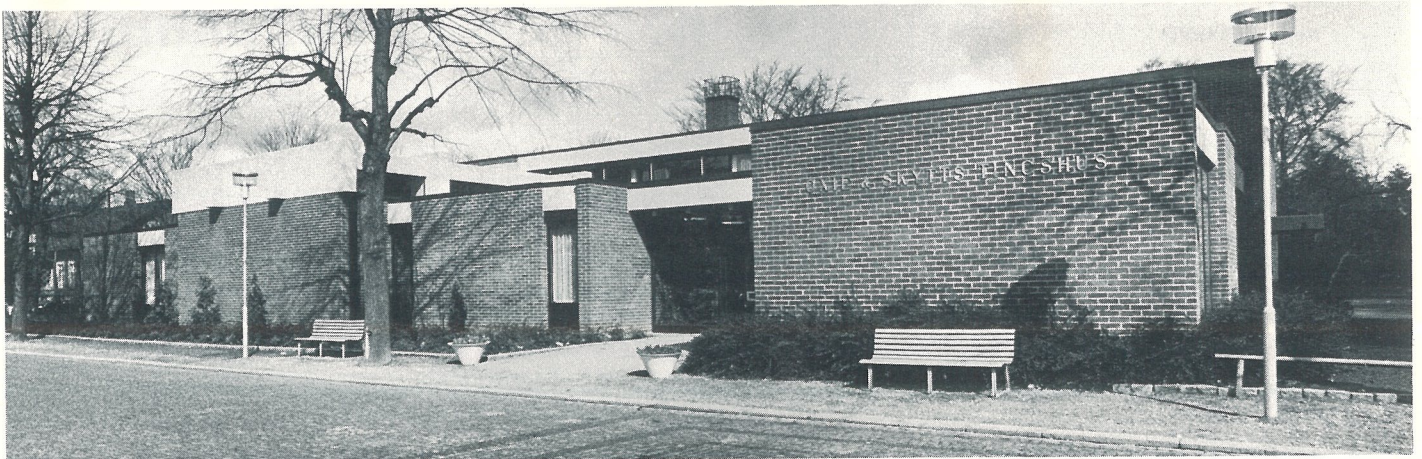
Oxie och Skytts tingshus byggdes 1971—1972 i Stadsparken med Fritz Jaenecke Arkitektgrupp AB som arkitekt.
