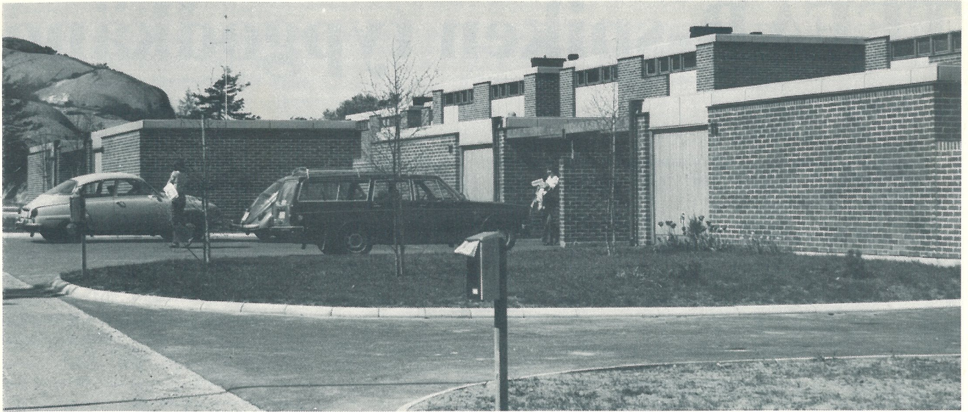
Garage och förråd längs bilgatan.
