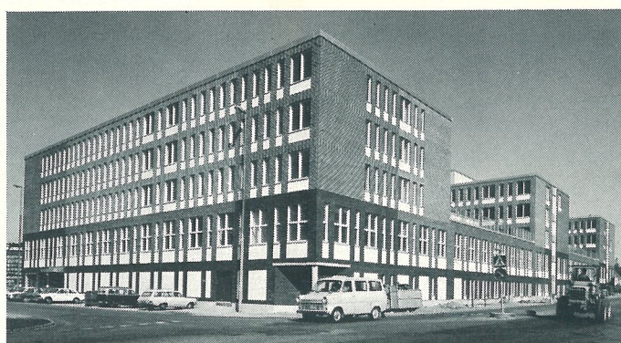
Kv. Tryckeriet i Stockholm — 300 ton färgat H-murbruk.
