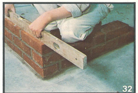
32) Under hela uppmurningen kontrolleras att stenarna läggs i våg.
