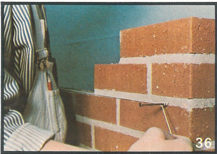
36) Murarsnöret fästs i en spik i fogen. Det är lämpligt att hålla en fluktmån av 2—3 mm mellan snöret och teglet. För att snöret inte skall komma för högt läggs snöret kring spik så som visas, d v s drag snöret u n d e r spiken och linda runt.
