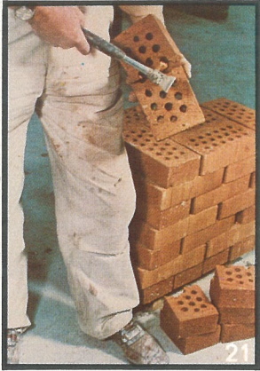
21) För att få stenar som passar in i tegelförbandet måste man hugga stenar. Halvstenar kan enkelt huggas genom ett slag med murarhammarens trubbiga ända mitt på stenens liggryta. Ofta hugger man flera stenar efter varandra för att ha på lager.
