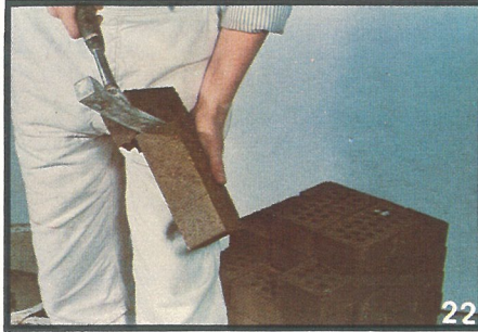
22) Vid andra längder än halvstenar huggs stenen genom att hammarens spetsiga ända riktas mot stenens långsida.
