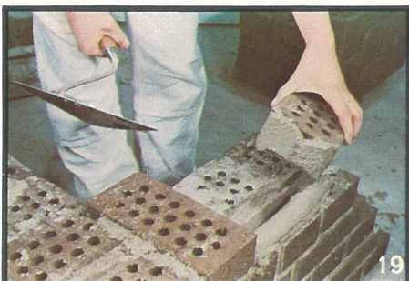
19) Bruket på murverket har här lagts ut och genom mursleven fördelats i två våldar. Härigenom ökar förutsättningarna att få helt fyllda fogar. Observera rikligt med bruk på stenens stötsida.
