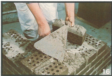
16) Bruket på slevan bredds ut så jämt som möjligt där stenen skall ligga. Lägg inte ut bruk för allt för många stenar på en gång. Vattnet sugs då bort från bruket innan alla stenar lagts på plats och vidhäftningen blir dålig.
