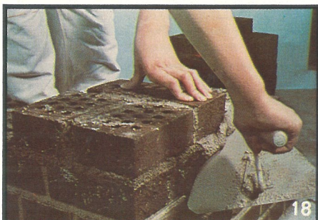
18) Det bruk som trängt ut dras av med mursleven så att fasadytorna inte smutsas.
