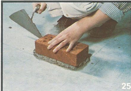
25) Hörnstenen läggs ut i bruk efter att den kommande väggens riktning markerats på underlaget.
