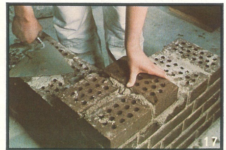
17) Lägg stenen snabbt på plats och pressa upp den mot tidigare lagda stenar. Bruket skall då tränga ut ur stöt- och liggfogen.
