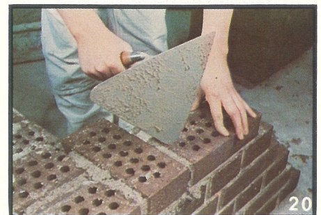
20) Stenens läge kan korrigeras med små lätta slag med mursleven.
