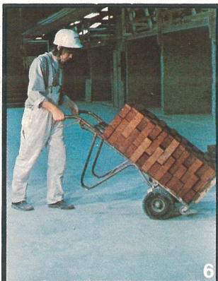
6) Teglet hämtas från upplag med tegelkärra och ställs upp så att det står lättillgängligt vid murning.
