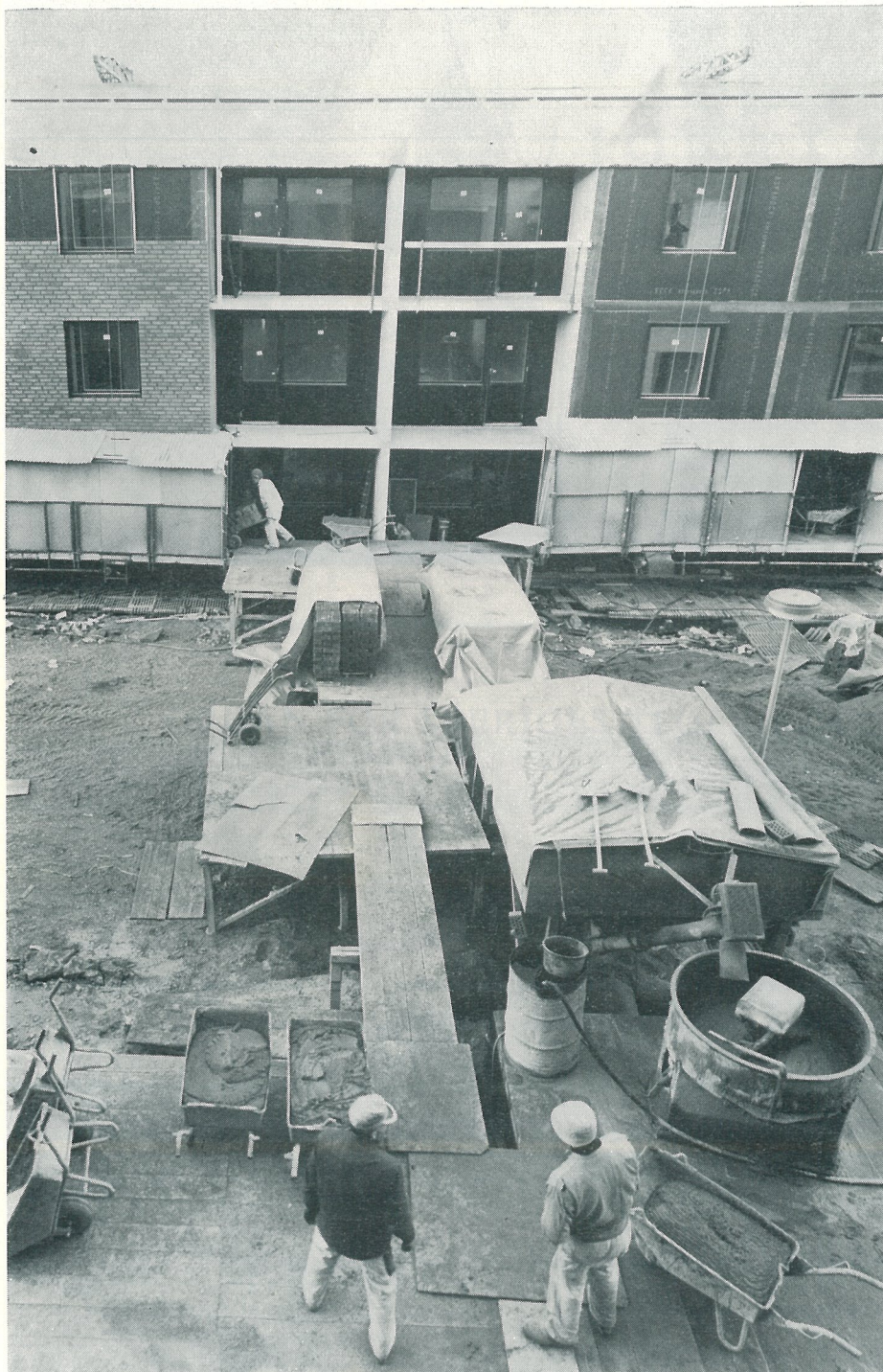
Lastbryggorna är mycket användbara. Här har man genom att sätta in en extra brygga sluppet flytta bruksblandaren.
