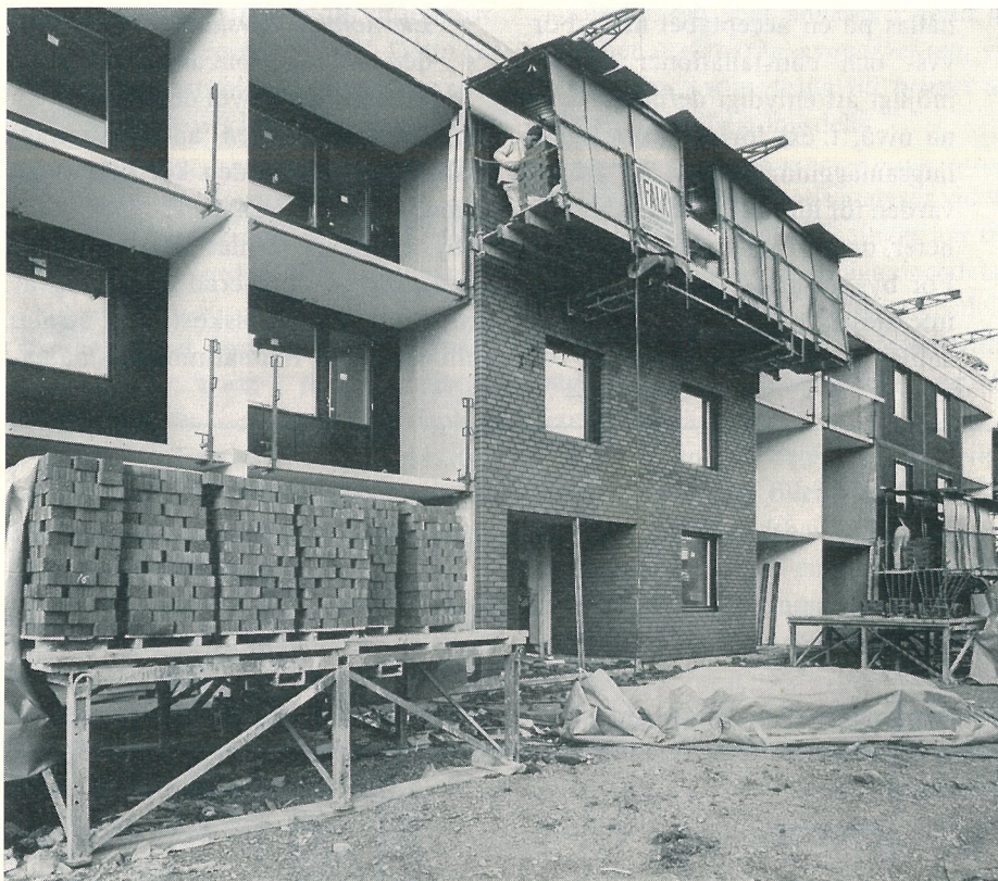
Laddning av ställningarna med tegel och bruk.
