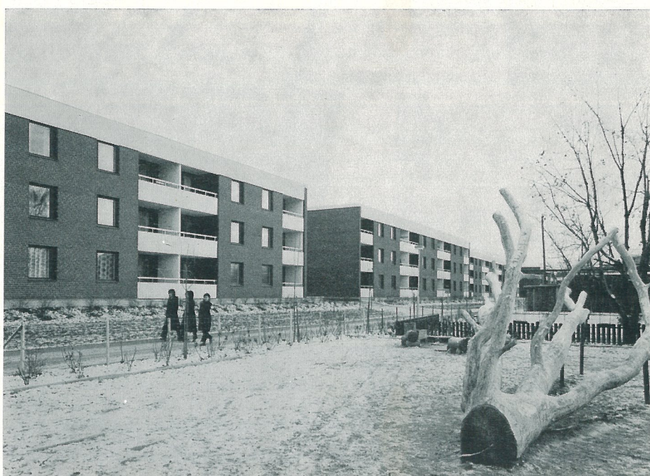
Billigare och snyggare hus blev resultatet av övergången från betongelement till utfackningsväggar av tegel.
