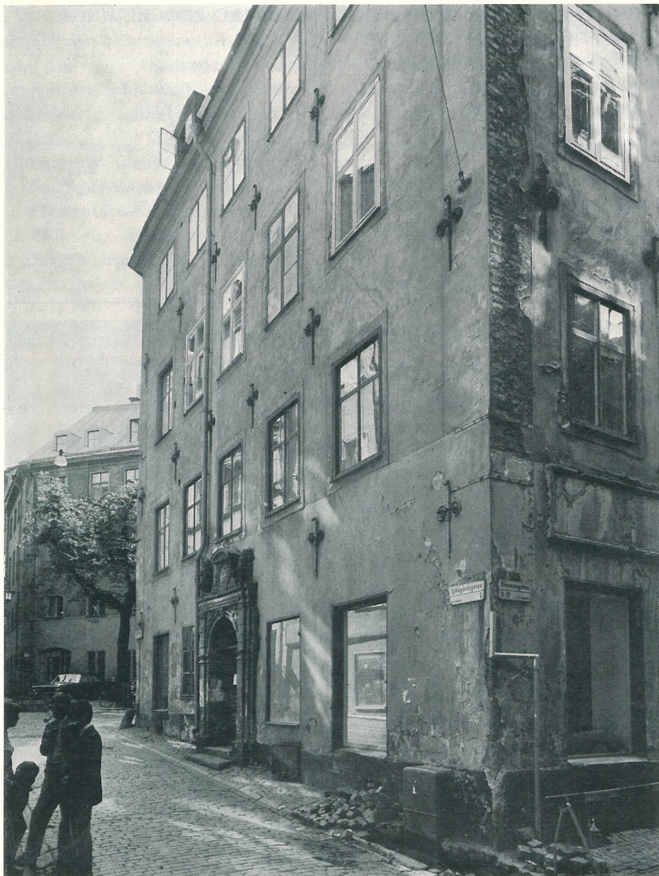
Fasad mot Själagårdsgatan—Köpmangatan före ombyggnad.
