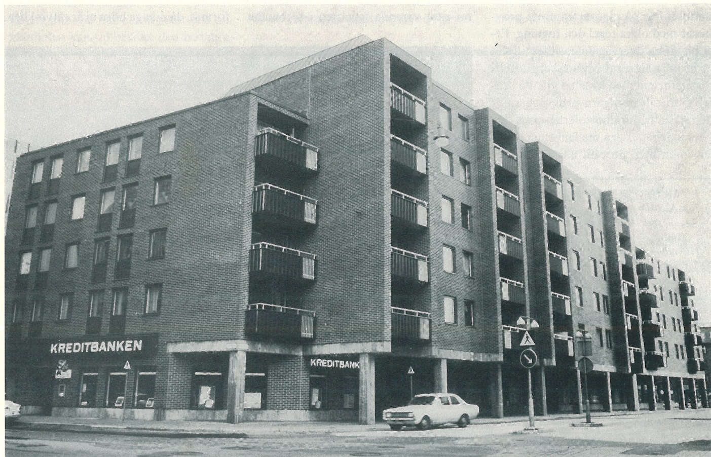
Etapp I:s bankhus, hörnet Östergatan—Mäster Nilsgatan.
