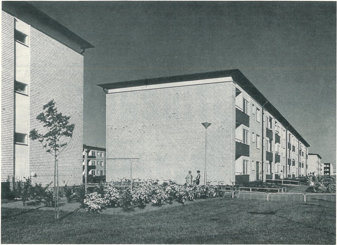
Bostadshus, kv Stagnélius, Norra Kvarngärdet, Uppsala, Svenska Riksbyggen, Arkitekt Kristian Kronström, Bergsbrunna gult chamotterat fasadtegel 7,5 × 25.
