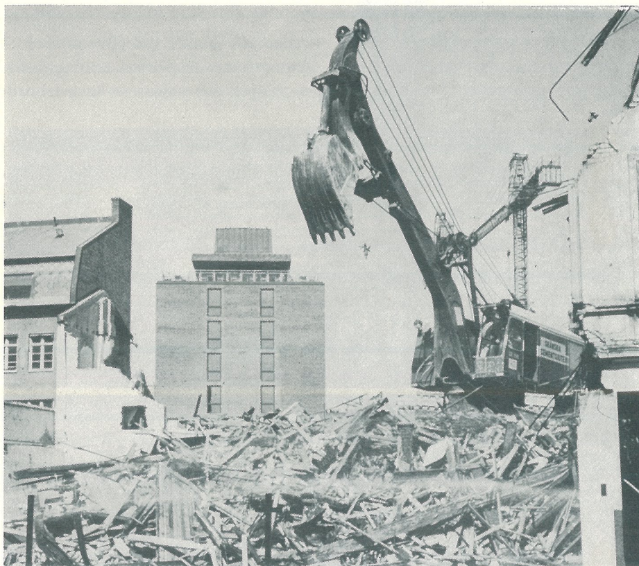
Rivning för etapp III. 7-vånings kontorshus för Försäkringskassan i etapp I syns i bakgrunden.
