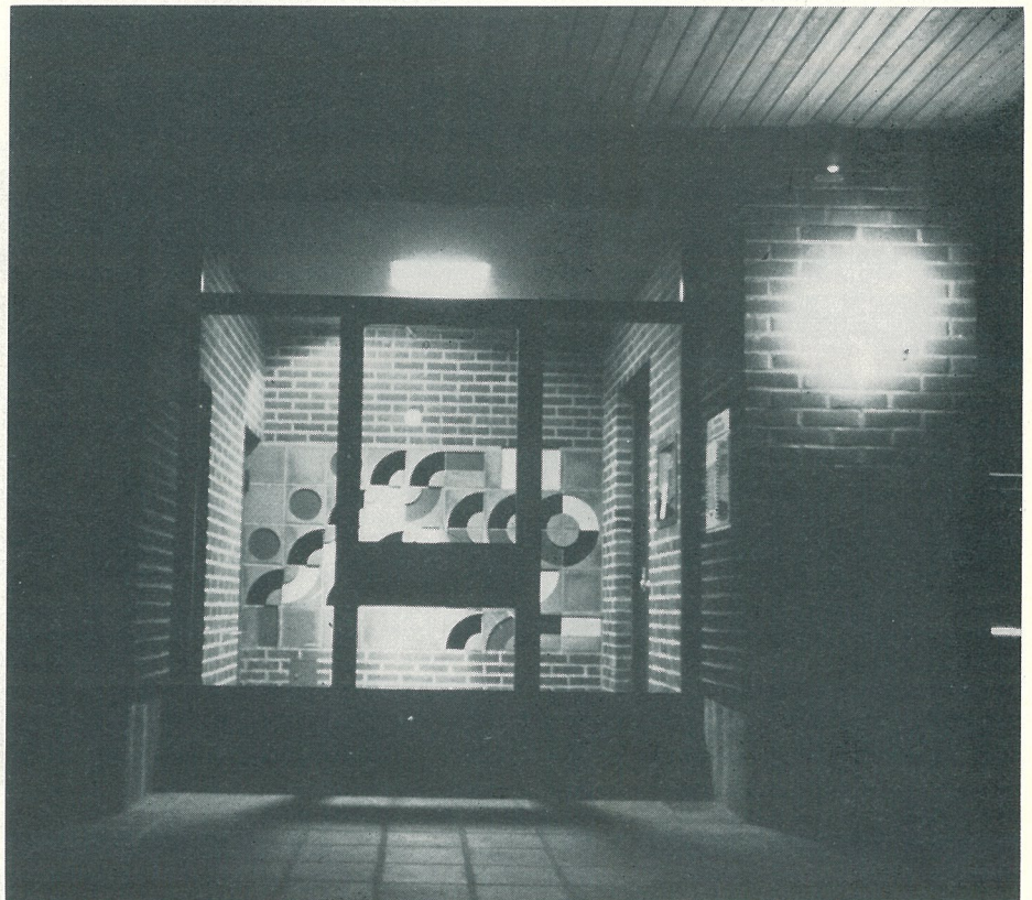
Bostadshusets entréer i etapp I har keramiska väggar av konstnär Knut Grane, Malmö.
