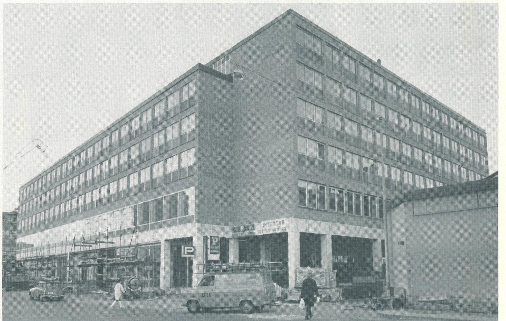
Hörnet Dragarbrunnsgatan—Klostergatan. Etapp B. Under den högsta byggnadskroppen finns ner- och uppförsramp till och från lossning/lastning samt parkering.
