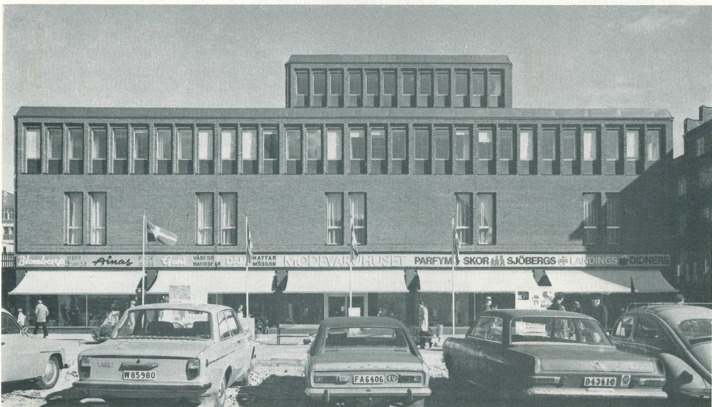
Mot Svartbäcksgatan från rivningstomten. Flaggstängerna bör, enligt arkitekten, ändras och helst tas bort.
