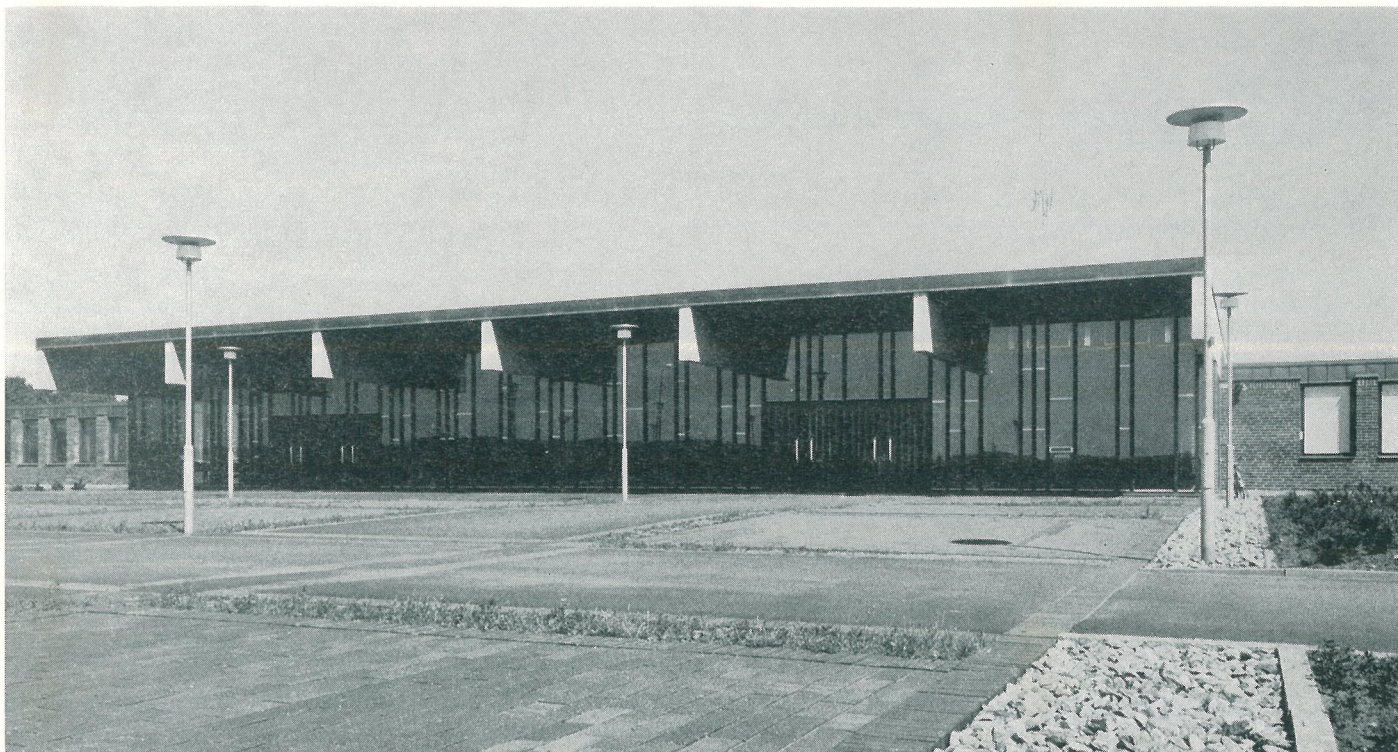
Huvudentré med el-uppvärmt marktegel från Hyllinge, prefabricerade betongbalkar och trapetsformad plåt i takkonstruktion.
