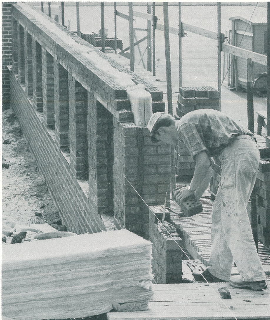
En av de många kanalväggar, som använts vid byggandet av Luftkonditionering AB, under uppmurning.
