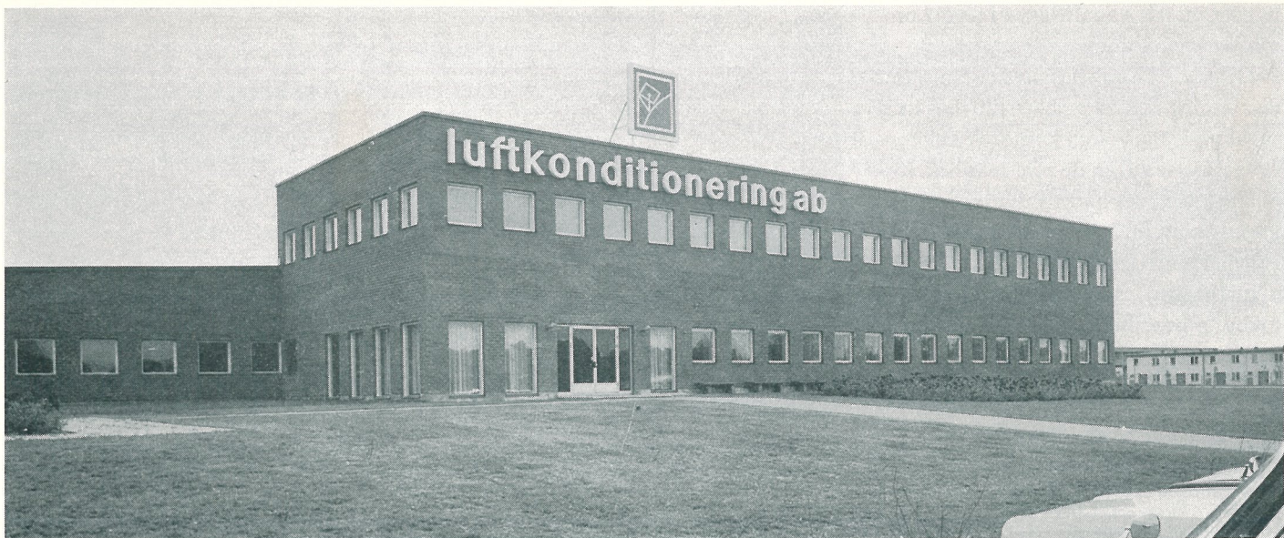
För såväl Luftkonditionering AB som Camfil AB har rött finsandat tegel från Sala Tegelbruk kommit till användning i ytterväggarna.
