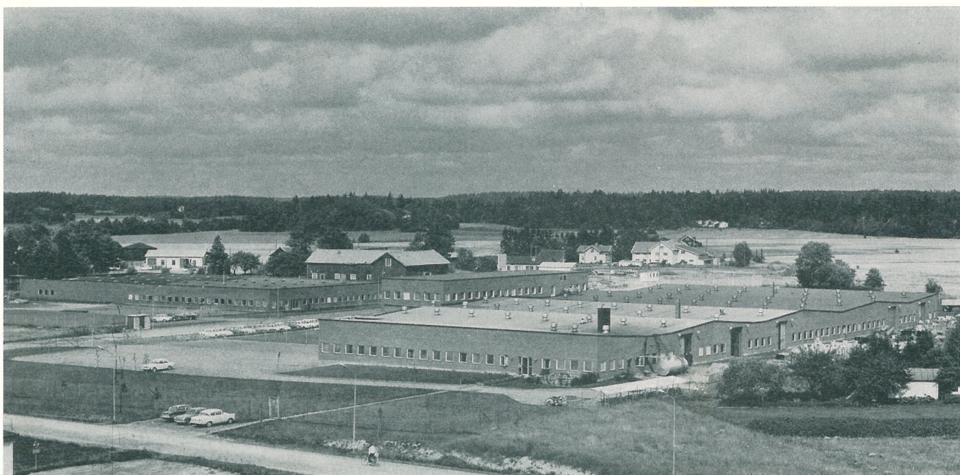
Luftkonditionering AB utgör med sina 6.800 m 2 en imponerande industribyggnad. Den två våningar höga kontorsdelen ses mitt på bilden. Längst t. v. ses den 3.300 m 2 stora industribyggnaden för Camfil AB.
