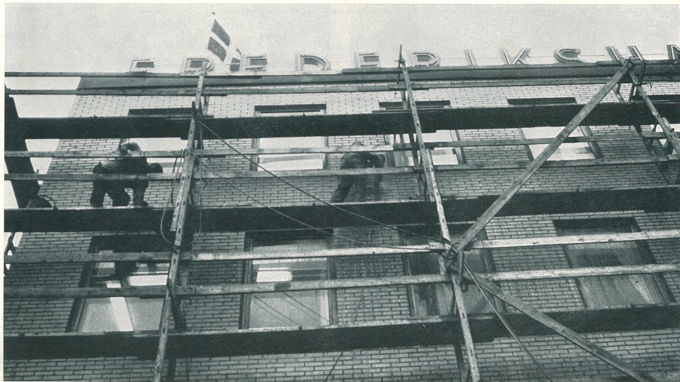
Fig. 9. Sprutning av södra fasaden, Kajskjul 53, Majnabbehallen, Göteborg
