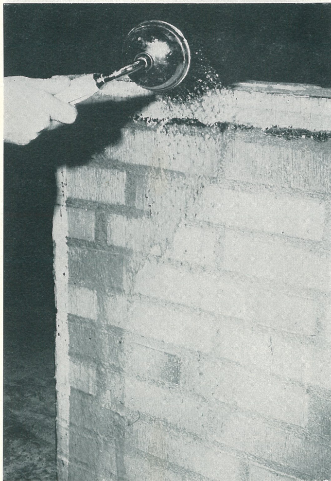
Fig. 5. Avspolning av tegelmjöl på fasadytan
