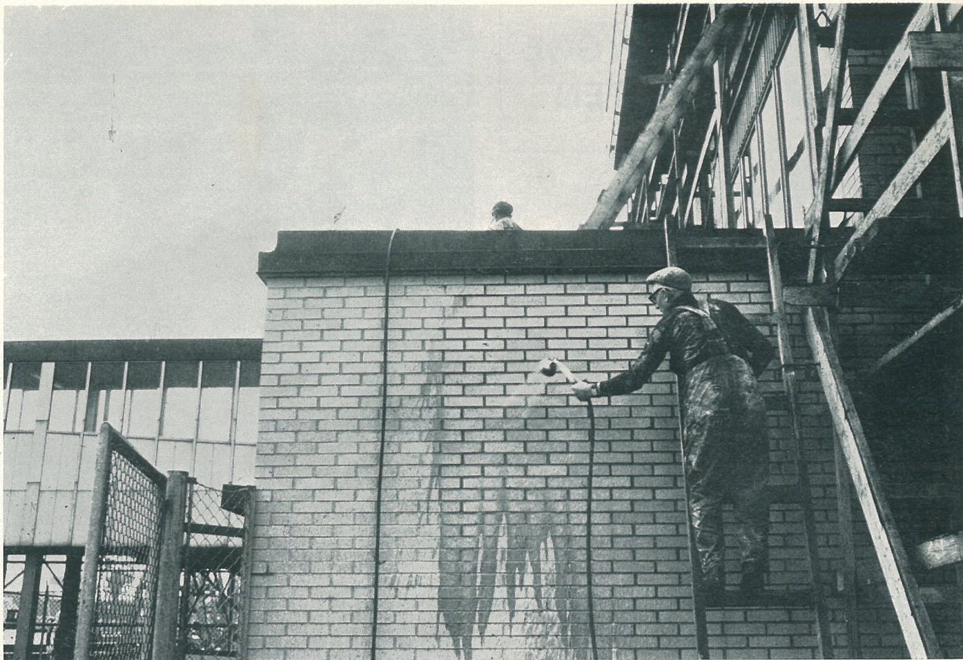
Fig. 10. Avspolning av lågbyggnad, Kajskjul 53, Majnabbbehallen, Göteborg
