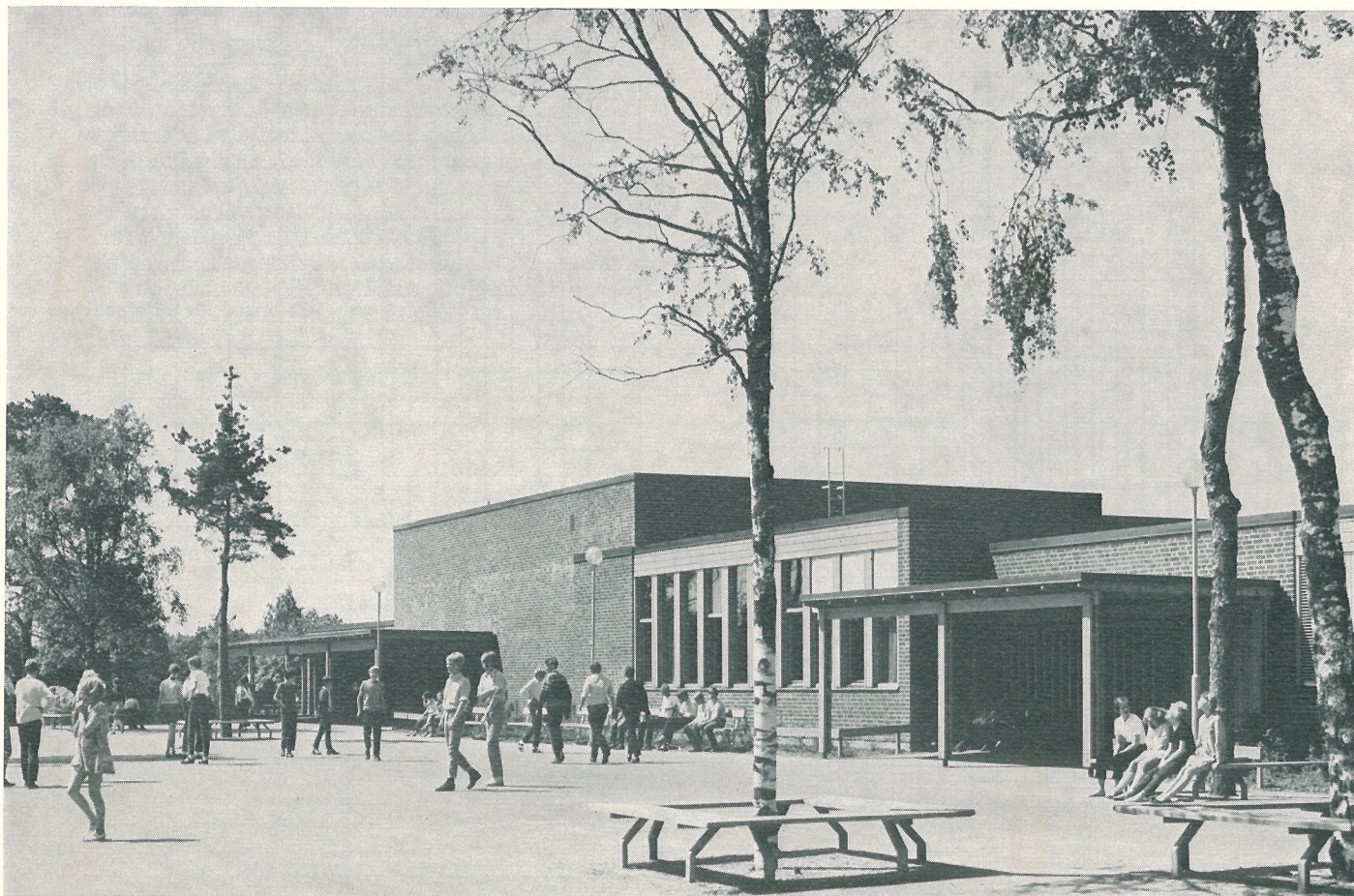
B-byggnaden från skolgården
