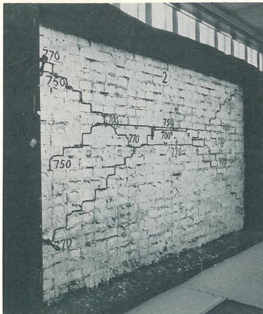
Figur 13 Provvägg 2 efter provning. Väggen var utförd med medvetet dålig murning.
