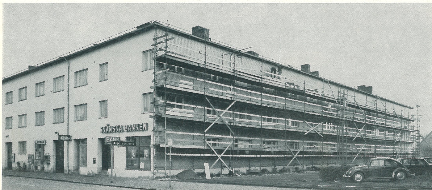
Bild 1. Cirka 1.000 m 2 fasadyta har Bostadsrättsföreningen Fäladsgården klätt med beklädnadstegel på en fastighet vid Lundavägen i Malmö.
