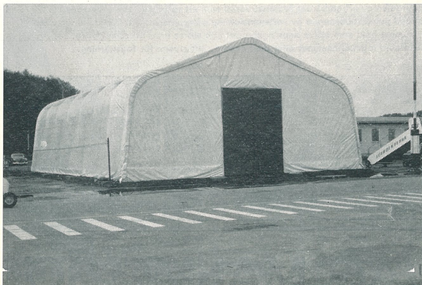
Förrådshall på Torslanda, Göteborg. Uppförd av Wilson & Co för tillfällig förvaring av reseffekter och liknande.
