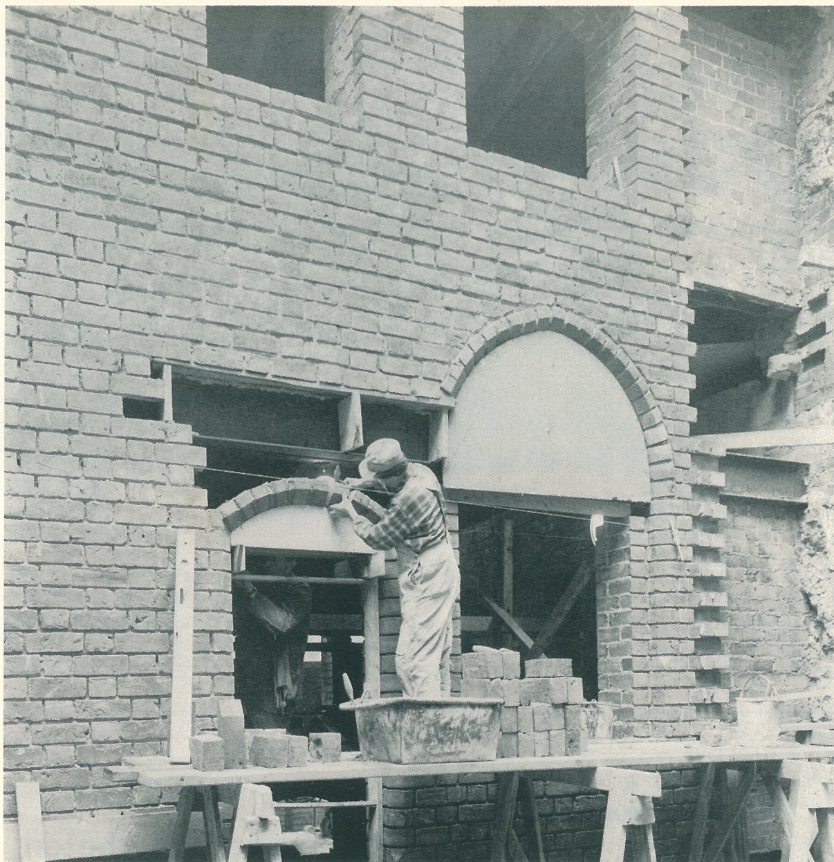
Murningsarbeten, Jörgen Kocks hus, Malmö
