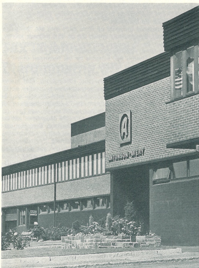
Vy mot huvudentrén. Den mörkröda tegelväggen krönes med svartbrun träpanel. Fönsternickerier i teak eller oljemålade i brunt. Bottenvåningen: mörkbrunt målade mot råspont gjuten betong.
