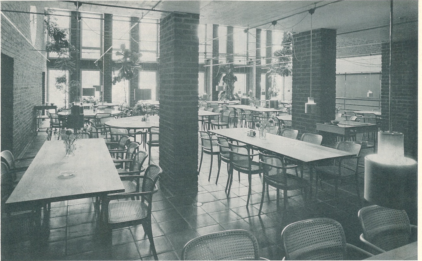
Interiör av matsalen med bärande tegelpelare.
