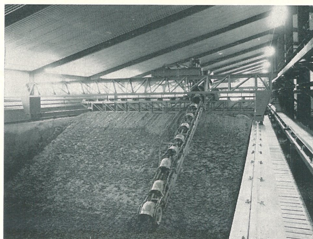
Grävmaskin med travers
