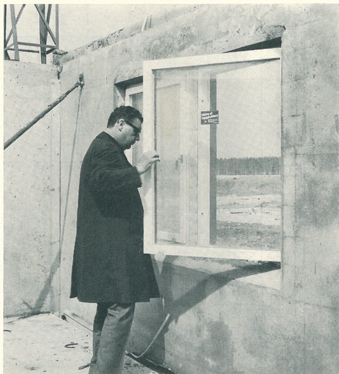
Överingenjör Lennart Adolfsson, chef för Ohlsson & Skarnes Uppsalakontor, kontrollerar det nyligen monterade väggelementet.
