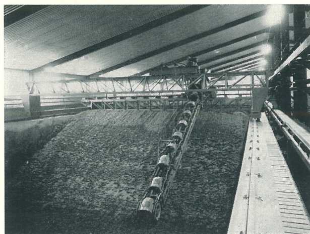
Grävmaskin med travers
