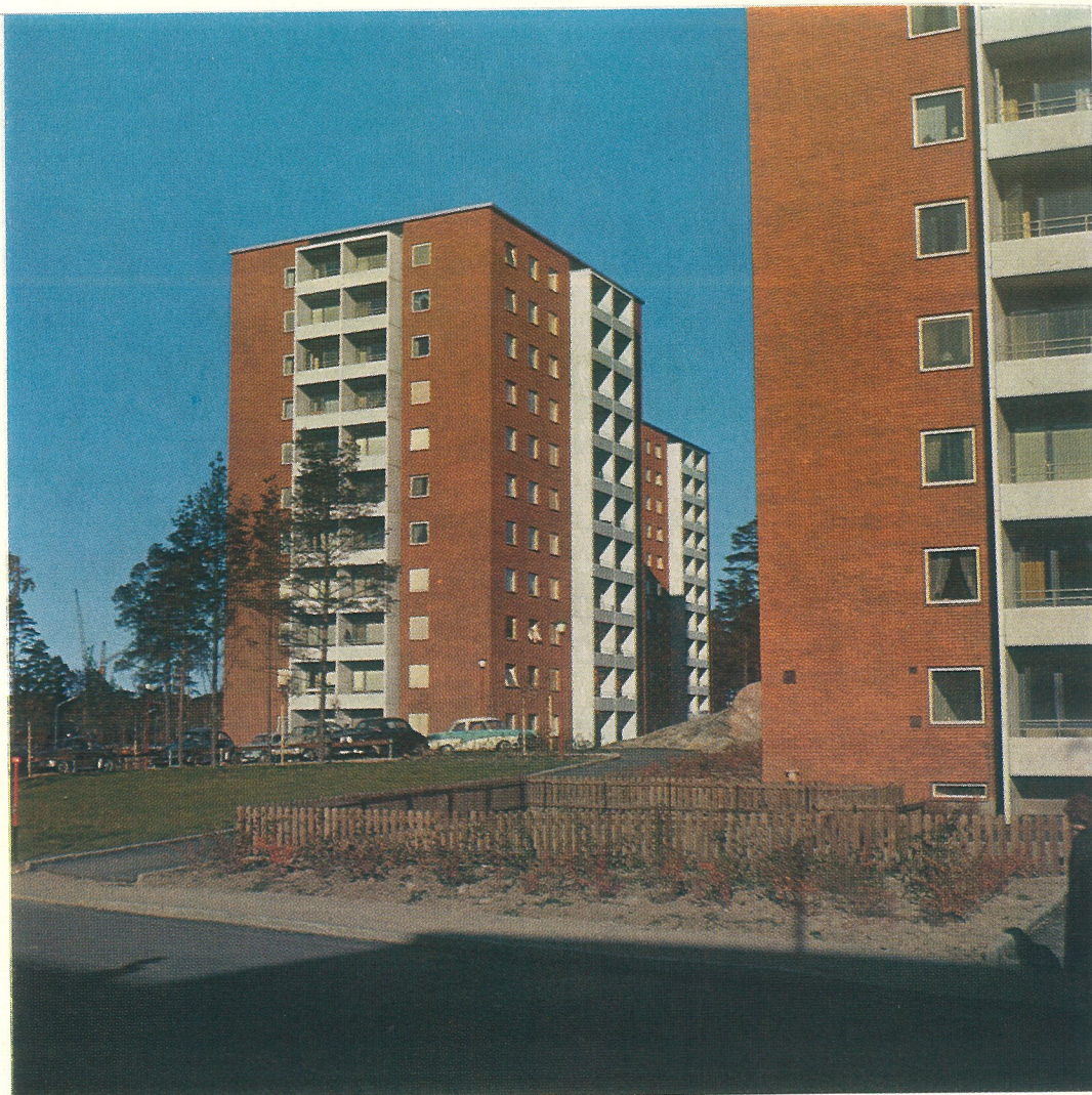
Höghus i Västerås. Arkitekter Horn & Sundling, Västerås.
