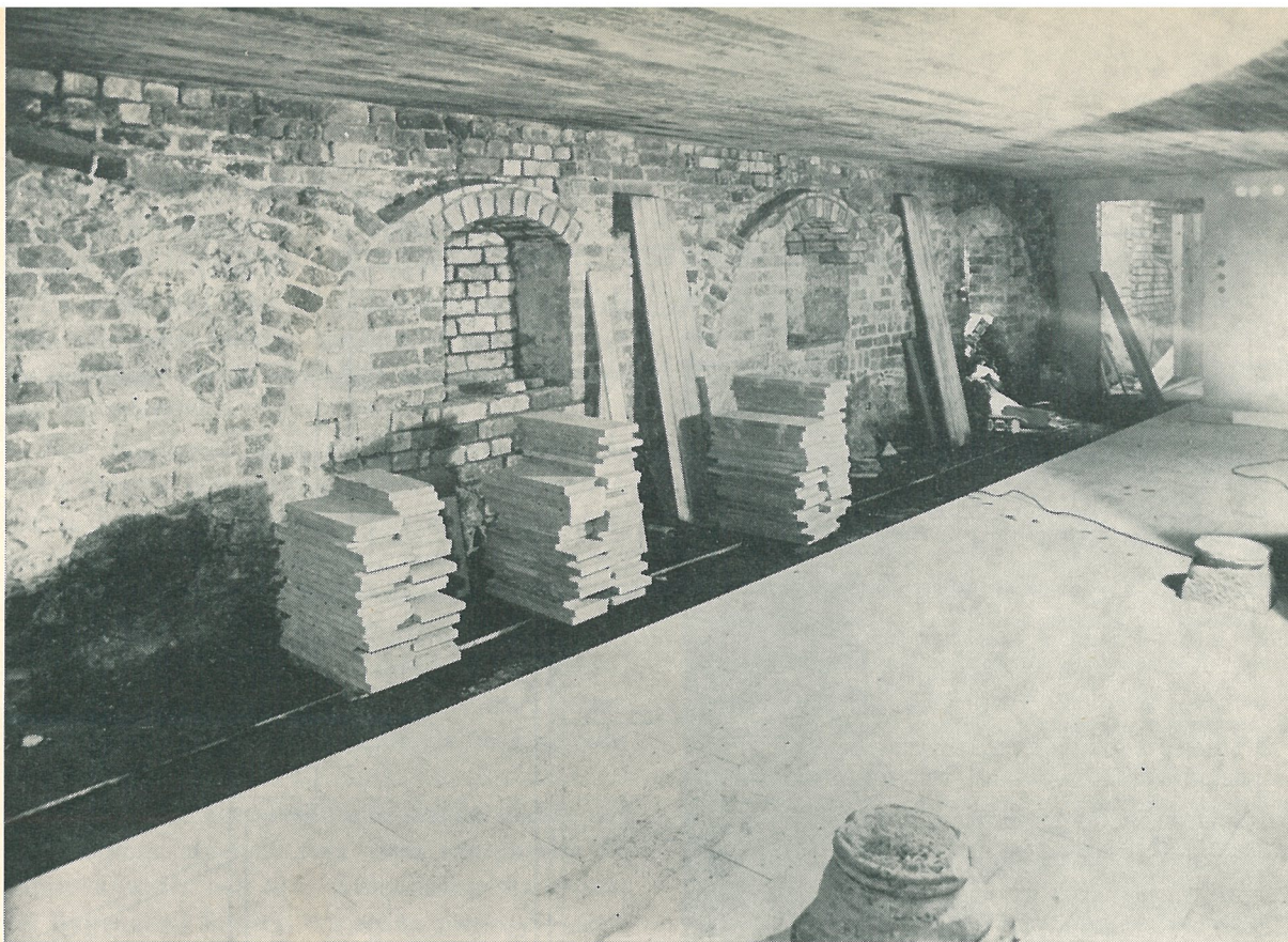
Golvet i museikällaren beläggs med kalkstensplattor. Ett par pelarbaser står kvar och antyder sträckningen av de valv som man ser rester av i väggen. I övrigt är det gamla murverket renblästrat och restaurerat, men de gamla källarfönstren har man varit tvungen att mura igen.
