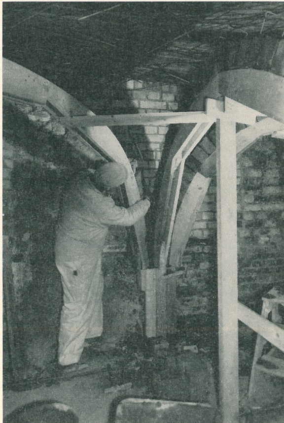
Stora murpartier av dålig kvalitet och utan antikvariskt intresse revs helt och hållet och ersattes av nytt murverk. Här återuppförs det rundade trapphuset.
