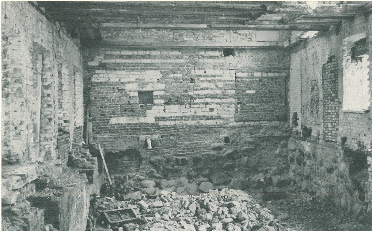
En annan bild av den frilagda interiören. Man ser de gamla grundmurarna och i fonden ett medeltida murparti med igensatta muröppningar från skilda epoker.
