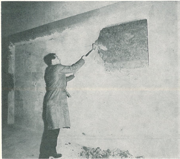
Verkmästare Georg Eriksson vid tegelindustrins försöksstation river tegelplattväggen, så att den första egentliga väggprovningen kan göras samma dag som laboratoriekontrollen sker. Foto: Hansell.
