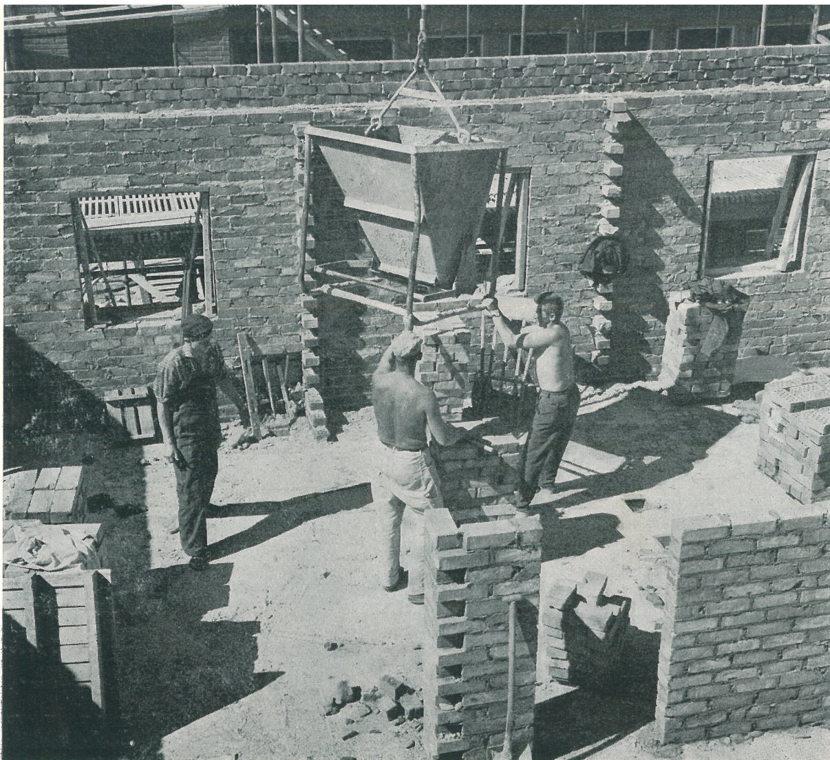
Bilden ovan visar en del av ugnshallens verkstadsparti under uppmurning. Foto: Kurt Hedö. Detalj 4 t.v. visar hur ugnshallens gavelvägg är ansluten till bärande och vindavstyvande stålbalkar.
