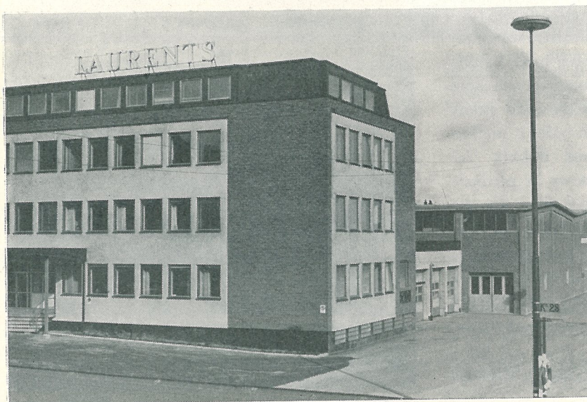
Kolimporten-Laurents har sina nya kontors- och lagerlokaler väl belägna vid Sundsvalls hamn. Utkragade och vitputsade partier i murverket ger byggnaden ett markant utseende. Foto: Tegel.
