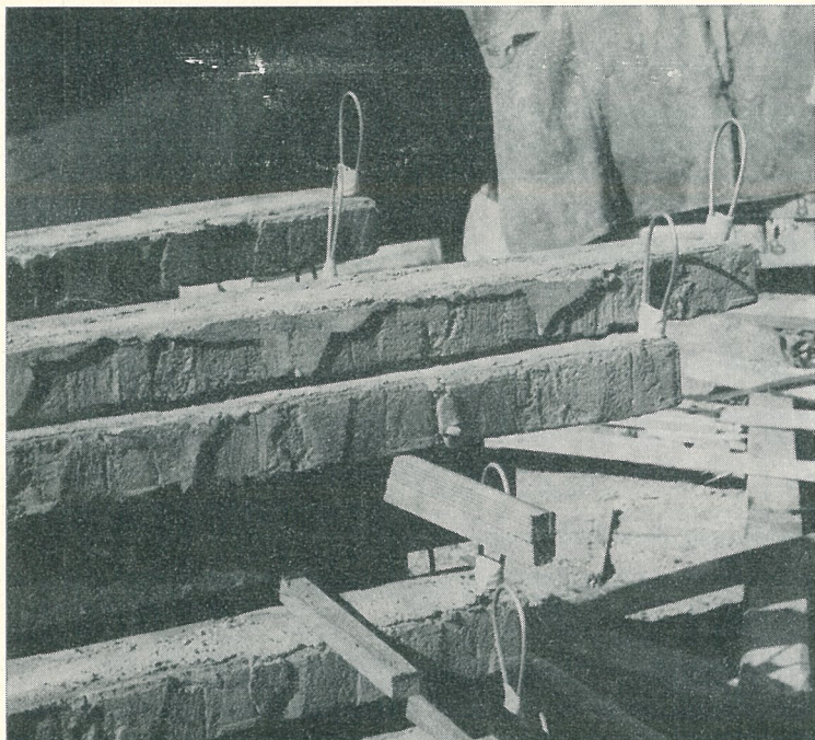
Fig. 7. De förtillverkade tegelskiften med förspänd armering försågs med speciella öglor av rostfri tråd i vilka de hängdes upp. Nedre delen av öglorna lindades med maskeringstejp för att de inte skulle bli stumt fastgjutna utan kunna ta upp eventuella rörelser mellan stomme och skal.
