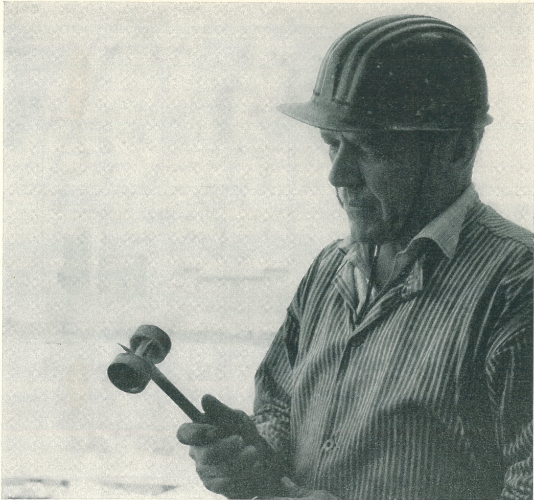
Fig. 10. Vid kratsningen av fogarna i fasaden användes fogkratsan »Sulky», uppfunnen av en i murarlaget. Uppfinnaren ville dock vara anonym och låter här sin arbetskamrat Bertil Ehrling visa upp det praktiska redskapet.
