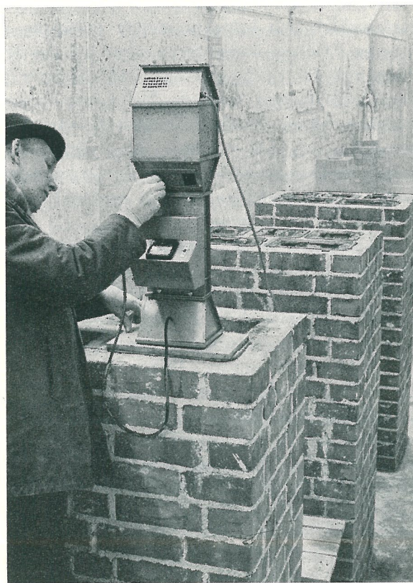
Fig. 9. Tätheten provas med ett EMF-instrument.
