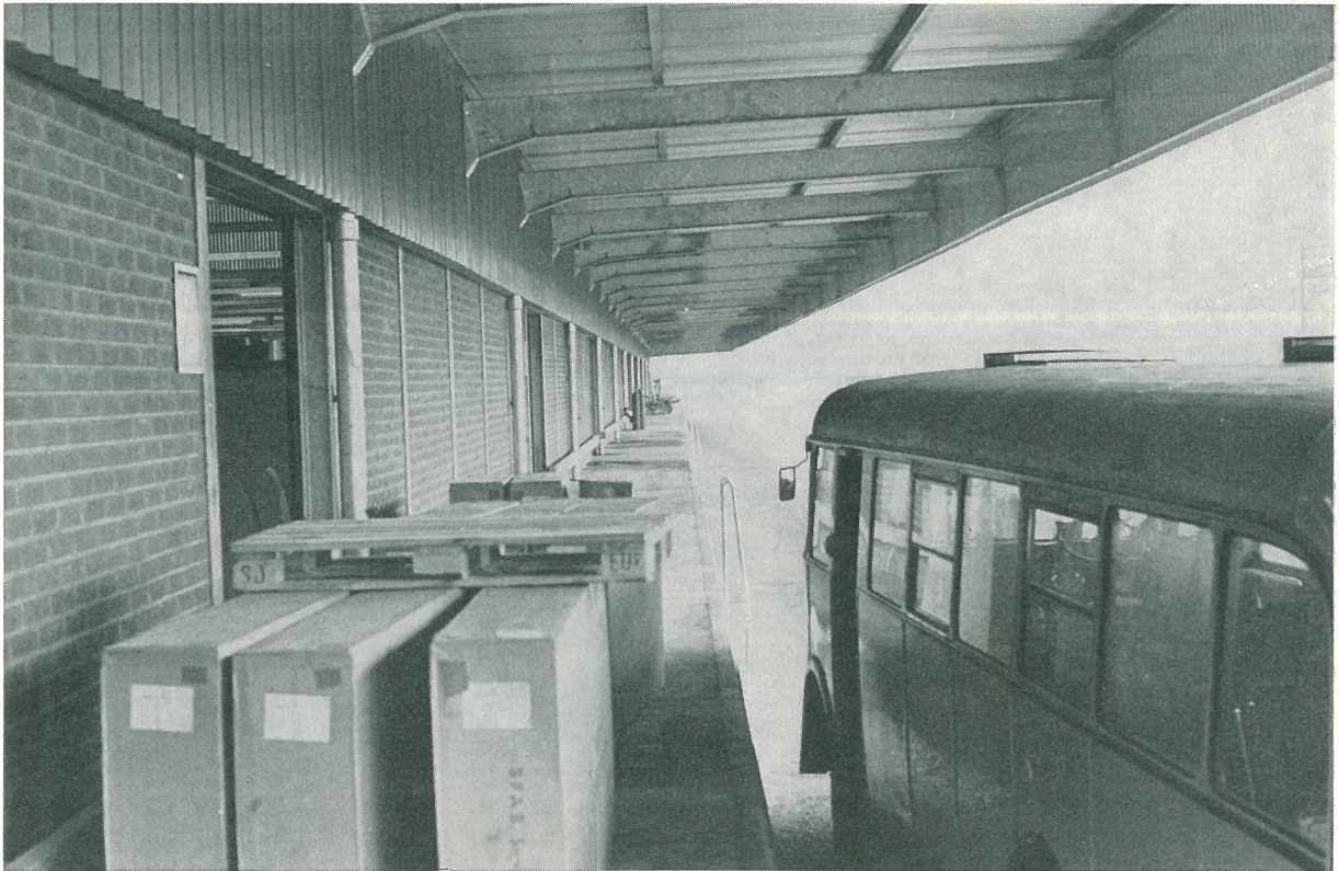
En buss har kört in till godsmagasinet kaj. Till vänster ser man hur tegelväggen utfackats mellan stålbalkarna.
