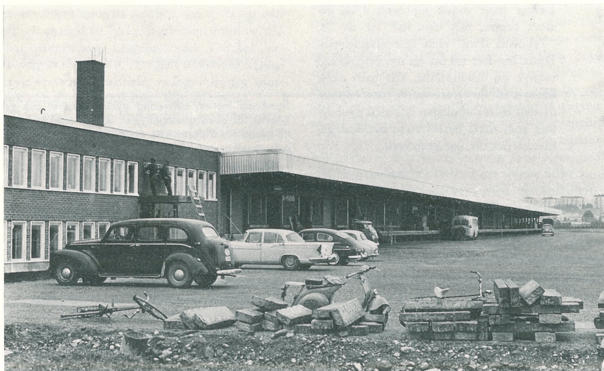
Knutpunktsmagasin i Gävle. Detta är en större anläggning med både expeditjonsbyggnad (t. v.) och gods- magasin (t. h.). Teglet är det material som dominerar arkitekturen.
