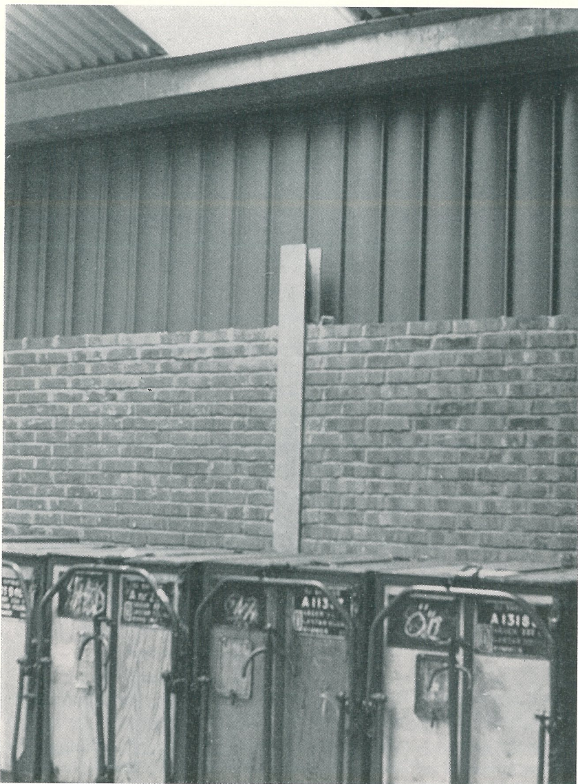
Interiörbild från godsmagasin visande en icks bärande pelare med utfackningsvägg av tegel. Pelaren är högre än tegelmuren för att man om så önskas skall kunna få plats med en jalousiports mekanism på pelaren.
