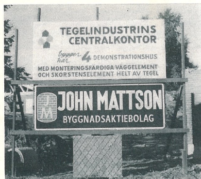
Byggskyltarna vid provhusen i Örmsta, Vallentuna. Under dem ett bröstningselement för flervåningsbygge.
