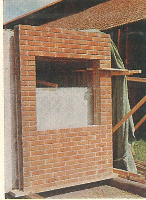
Med fönster och dörröppningar
