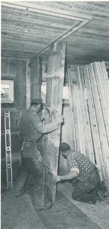
Innerväggarna monteras i spår i taket och klistras mot varandra.
