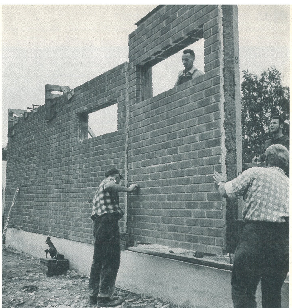
När monteringen finslipats räknar man med att kunna montera elementen till minst en villa per dag.
