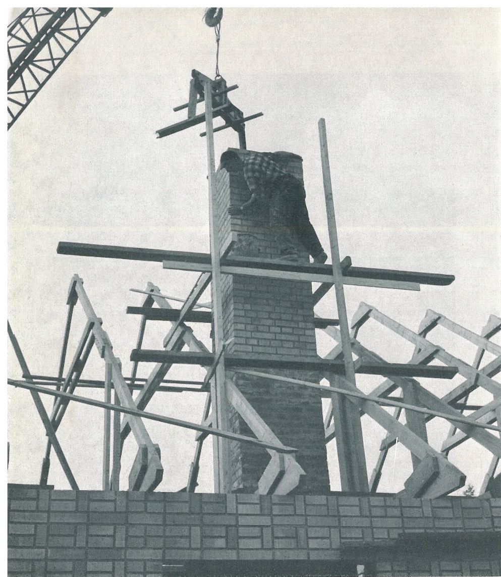
Det femte skorstenselementet lyfts på plats. Varje element väger ett ton.
