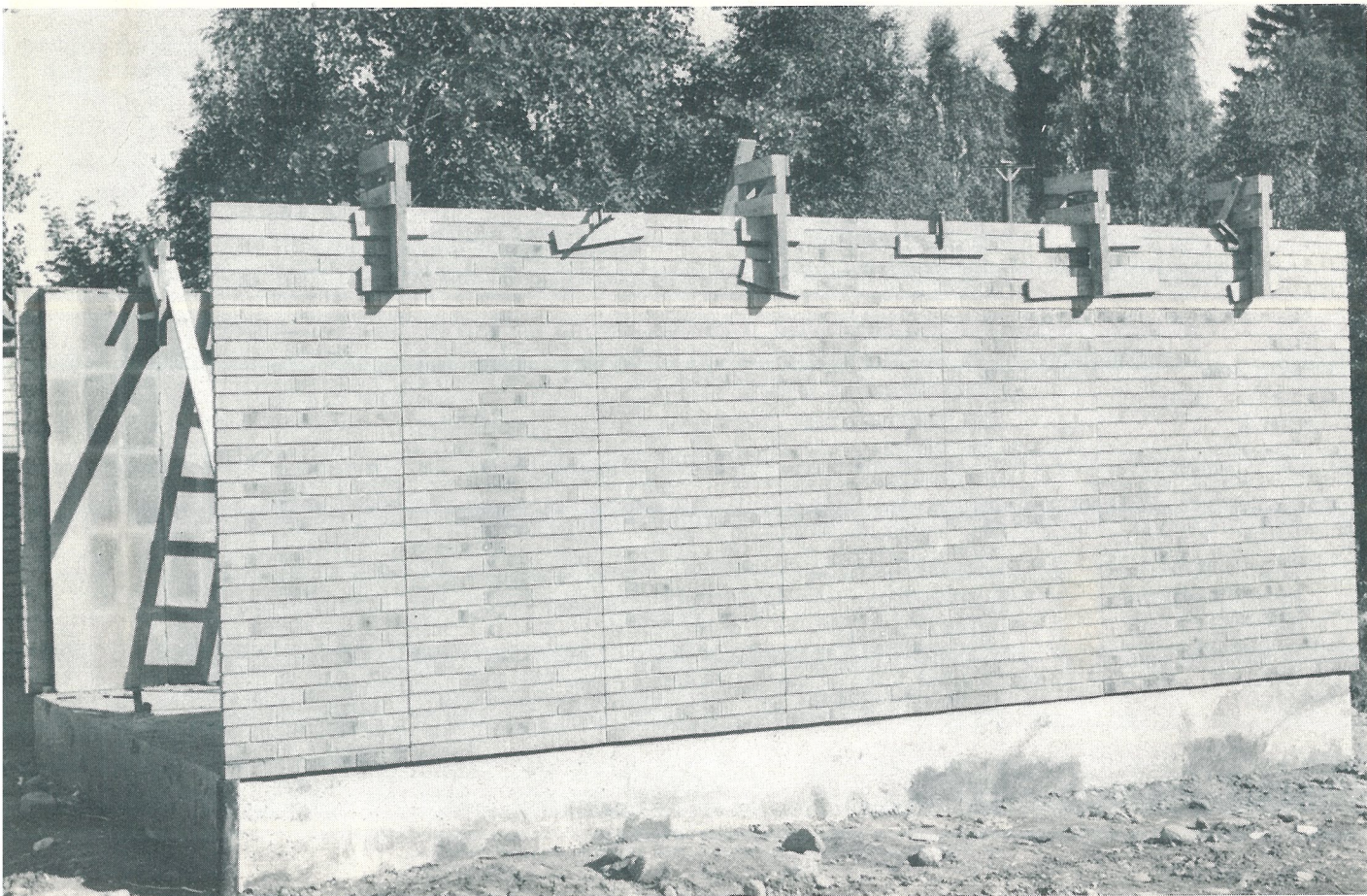
Garagebyggnad. Elementen stagas här med enkla träklamrar. Fasadens skarvar mellan elementen räknar man som en estetisk effekt.
