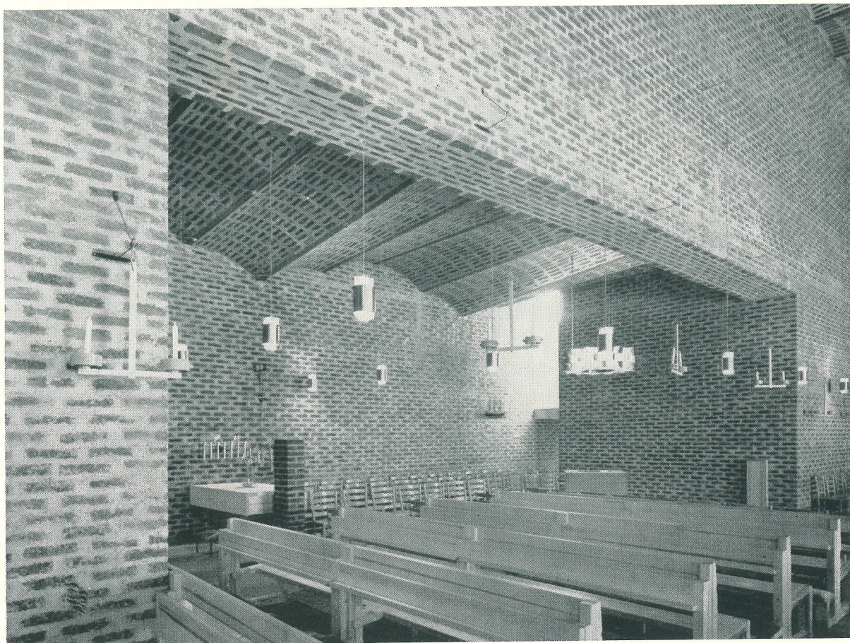
Interiör från Björhagens kyrka visande en av tegelbalkarna med sned skjuvarmering samt de med olika lutning lagda tunnelvalven.. i taket.
