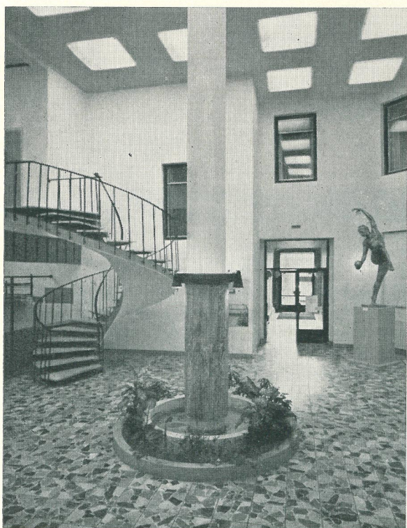
Landskrona. En gammal bakgård byggdes över på två våningars höjd, plastkupoler ger ljus, Terrazzogolvet, en fribärande trappa samt växter och springvatten runt pelaren ger rummet liv.
