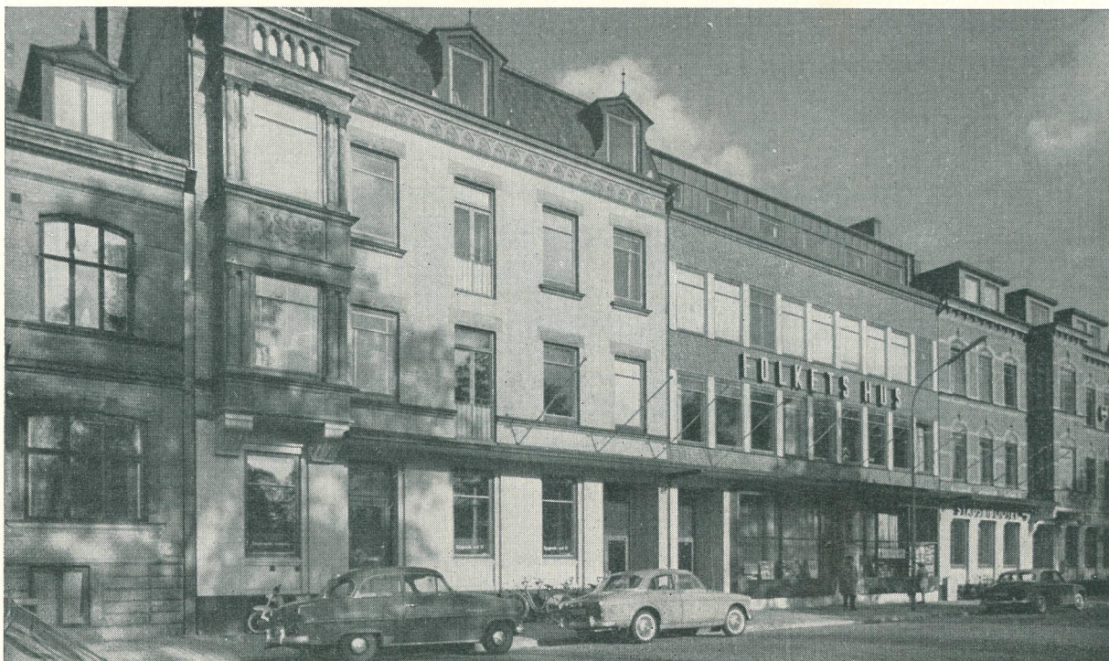
I Landskrona äger Folkets Husföreningen större delen av ett kvarter där ungefär varannat hus rivits och genom ny- och ombyggnader givits en funktionsduglig enhet med goda kommunikationer. Fasaden hålls ihop genom bottenvåningens färg och genom ett skärmtak samt byggnadsmaterialet i tegel.
