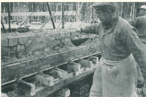
Fig. 10. Innan fasadskiften muras täcks armeringen omsorgsfullt med bruk.
