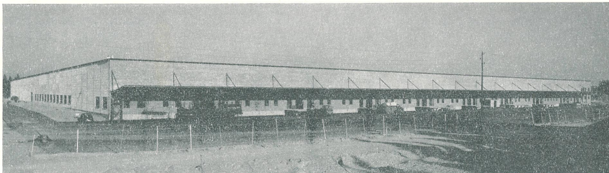
Ahlén & Holms lagerbyggnad i Jordbro med utfackningsväggar i kanalmurkonstruktion av tegel.
