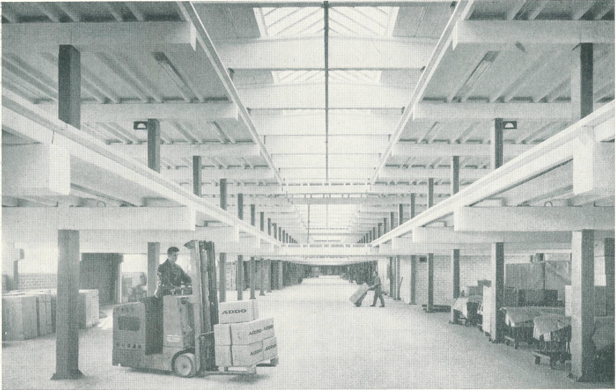
Interiör av förrådet, som är dimensionerat så att all hantering skall kunna ske med gaffeltruckar. På vissa partier kan det öppna mittutrymmet byggas över med förtillverkade bjälklagselement om lagerutrymme behövs ökas.
