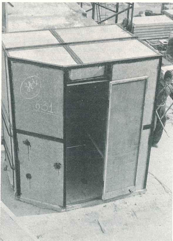
Fabrikstillverkad badrumsenhet, bestående av asbestcementskivor monterade på järnramar. Enheten innehåller ett badkar, ett tvättfat och ett wc.
