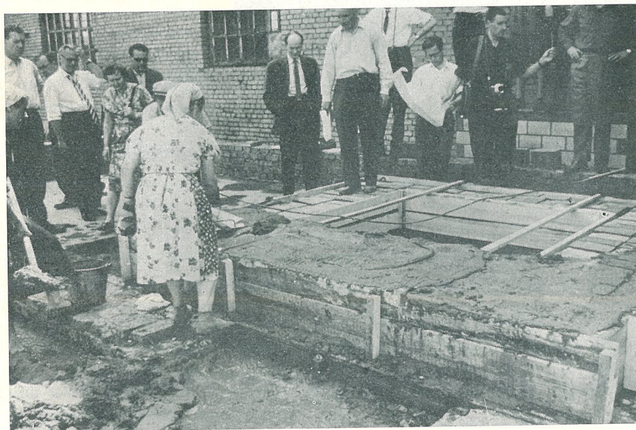
Demonstration av väggelement vid den statliga byggforskningsinstitutionen Rosniims i Kraskovo. Elementen består av från fasadsidan räknat ett lag gula tegelplattor i förband, ett lag bruk, tegelhålblock utan förband, ett lag bruk.
