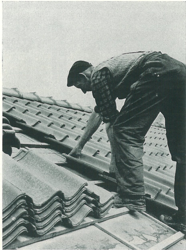
På övre bilden läggs det falsade takteglet ut av snickare Olof Ekefält.
