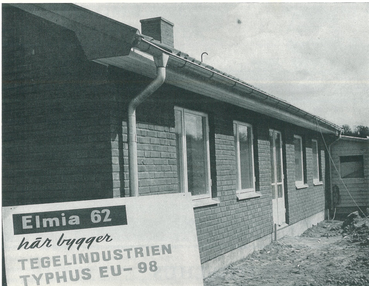
På södersidan finns utgång från vardagsrummet till en skyddad uteplats. När tomten är färdigplanerad ligger markytan betydligt närmare teglet.
