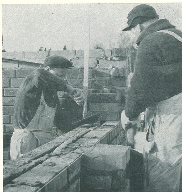
Karminfästningen i kanalväggarna i ing. Ludvigssons byggen klaras elegant genom att en skumgummilist, A, spikas på karmarna. Den blir ett utmärkt mothåll vid drevningen (ovan). T. h. muras ett trapphus i kv. Rönberga. Lägg märke till den ljudabsorberande mineralullsskivan som muras in i väggen.
