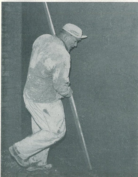
Omedelbart sedan putsen sprutats på dras den av med rätskivan och bearbetas med skånskan. Tack vare sprutningen kan flera män arbeta samtidigt på väggen. Murarbasen Gösta Nordin har här hjälp av Verner Kvarnback (ovan och nedan).
