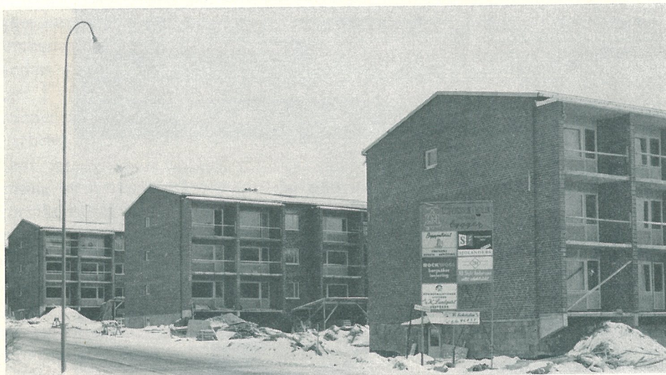
Fastigheterna i kv. Klockartorpet är i det närmaste färdiga.
