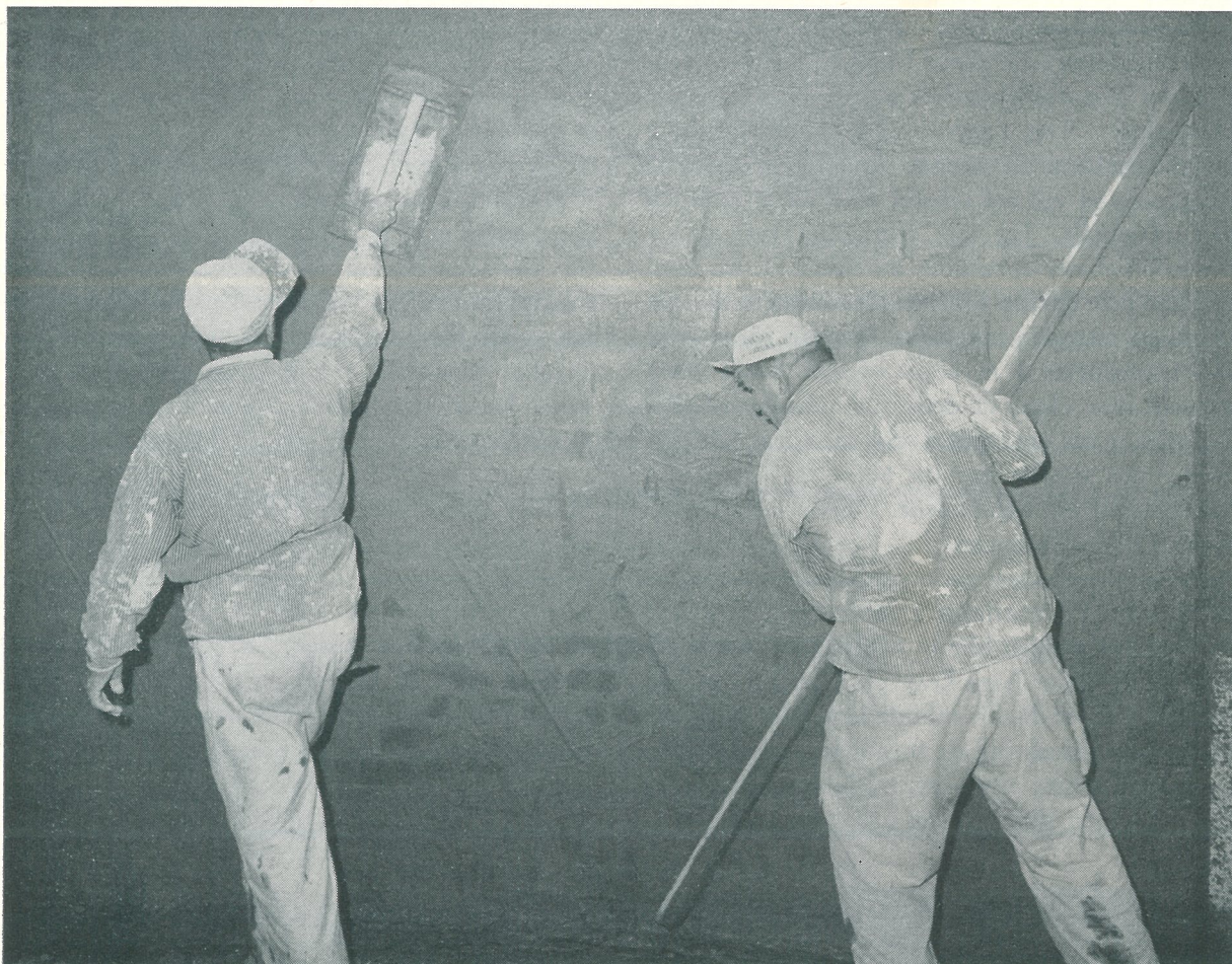
Omedelbart sedan putsen sprutats på dras den av med rätskivan och bearbetas med skånskan. Tack vare sprutningen kan flera män arbeta samtidigt på väggen. Murarbasen Gösta Nordin har här hjälp av Verner Kvarnback (ovan och nedan).
