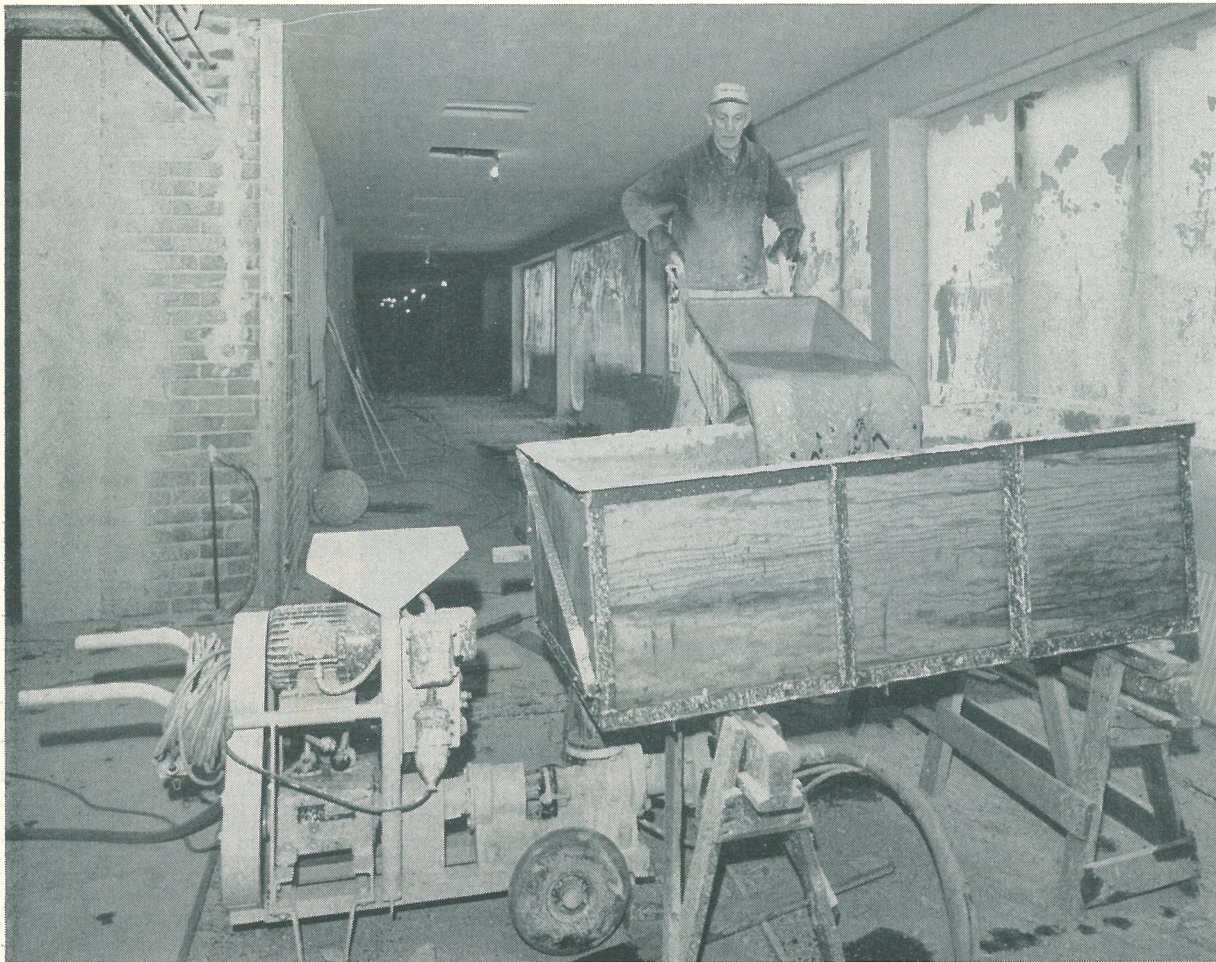
Med en lave kopplad till pumpen får man en effektiv bruksförsörjning till sprutan. Hans Rydman tippar just en kärria bruk i laven.
