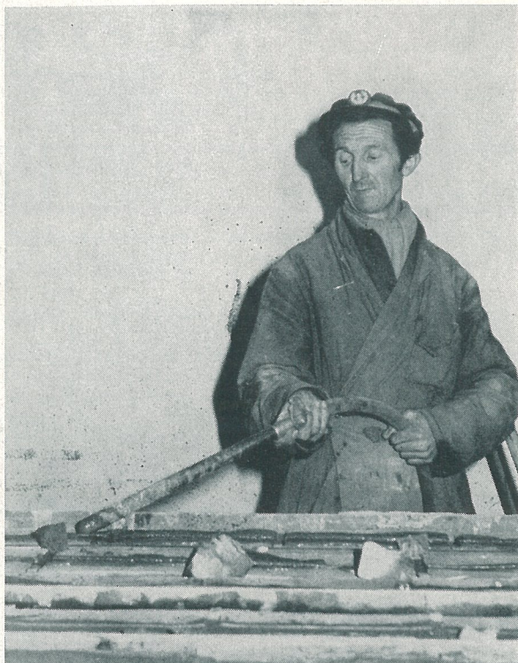
Med ett fastsvetsat stift på en vanlig betongvibrerare sätts armeringstråden i svängning och betongen vibreras till fullständig utfyllnad.
