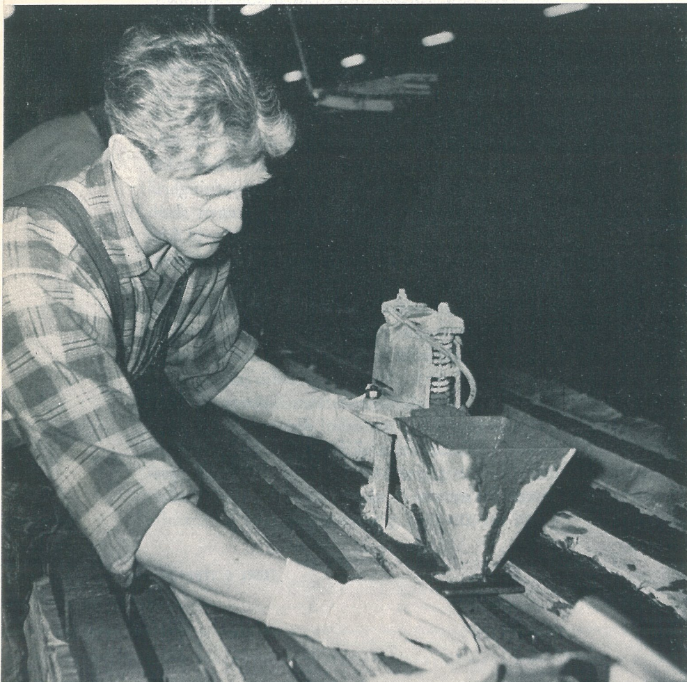
Betonggjutning enligt Sköldingemetoden. Betongen vibreras ned i spårerna där den förspända armeringstråden ligger.
