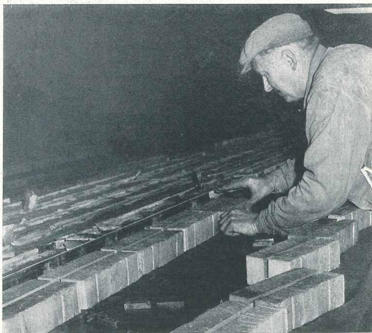
Tegelstenarna som skall ingå i de förspända skiften läggs ut i långa rader på spännbordet med distansklotsar emellan.
