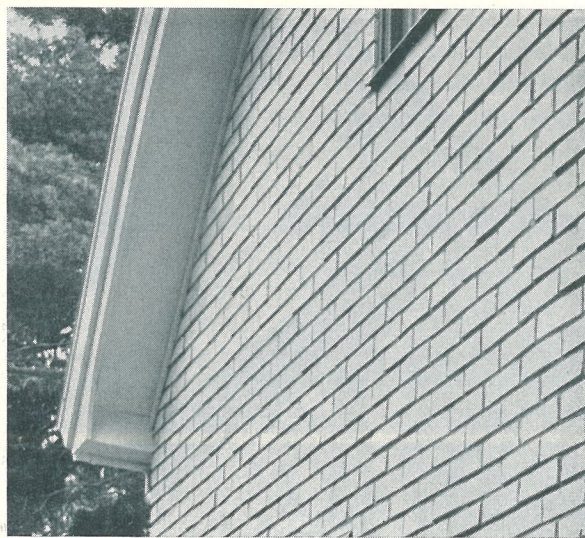
Fig. 10. Vid avslutningen mot taket kan tegelplattorna huggas och den yttersta kanten liksom på bilden täckas med en list.
