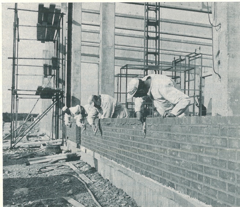
Typiskt för kanalväggen är att fogningen utförs över hand.
