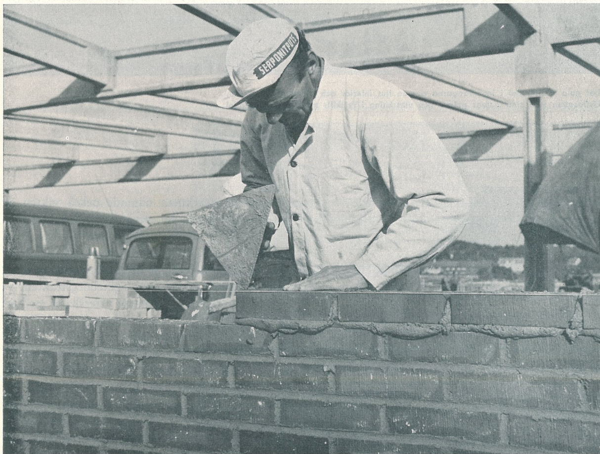
Göteborgsklimatet kräver att murningen sker med väl fyllda fogar.
