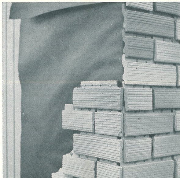
Fig. 7. Detalj av hörn enligt fig. 5 under uppsättning. Pappen och tegelplattorna har spikats direkt på den gamla stående ytterpanelen.
