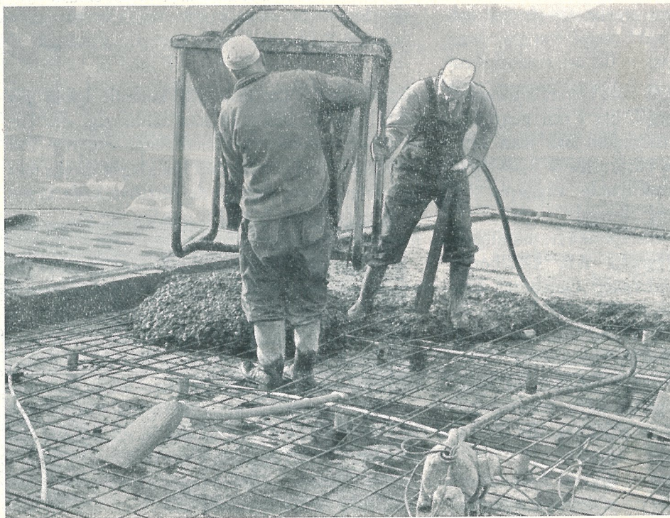
Bjälllagen gjuts direkt mot isoleringsskivan
