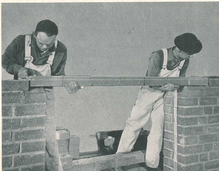
Snabb och enkel valvslagning med förtillverkade armerade tegelskift.
