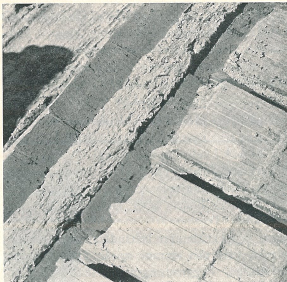
Förtillverkade, armerade tegelbalkar som bjälklagskonstruktion i förening med kanalväggar ger en snabbyggt och ekonomisk villakonstruktion.
