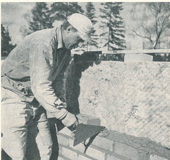
I kvarteret Ormkärr i Hagsätra bygger Danielssons Entreprenad AB två längor fyrvåningshus för HSB. Husen har kanalväggar med fasadtegel, och speciell omsorg läggs ned på att fasadmurningen skall bli av så hög klass som möjligt.
