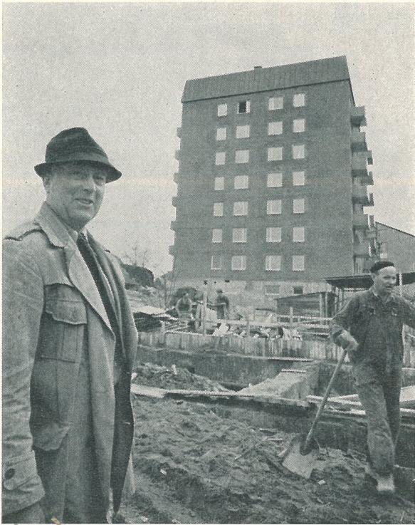
Verkmästare Georg Olsson är belåten över att det gått så snabbt att få upp 7-våningshusen med kanalvägg.
