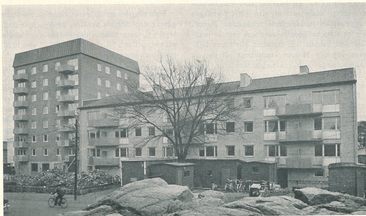
I Oxelösund har byggts ett par 7-vånings kanalväggshus, förmodligen de högsta i sitt slag i landet. Husen är sammanbyggda med lamellhus, även de i kanalväggskonstruktion.
