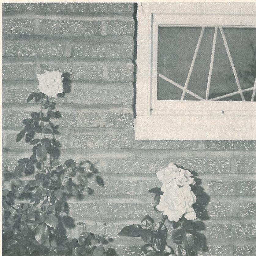
Ett parti av den eleganta tegelfasaden på köpman Börje Anderssons villa i Tibro. Liggfogarna är breda och blåsvarta, stötfogarna är smalare och bruket tegelrött.
