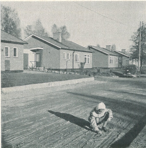
Nya rad- och kedjehus av tegel. Fogbruk i olika färger ger husen olika utseende.
