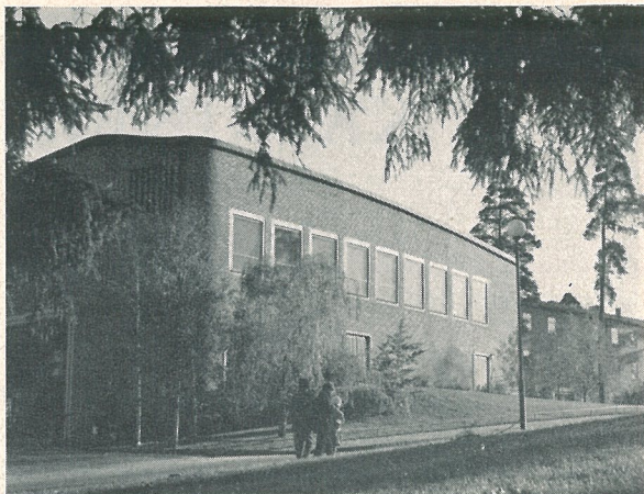
Läroverkets förnämsta blickfång är aulan. Byggnaden är uppförd i gult fasadtegel.
