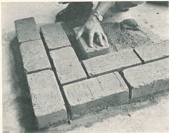
Bild 5. Tegelstenarna sätts i läggningsbruket utan fogbruk.
