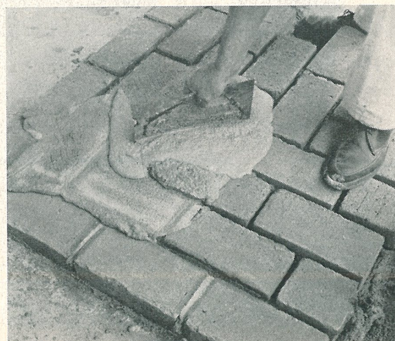
Bild 10. Fogbruket fördelas över golvet med gummispackel e. d. som man för diagonalt över fogarna.
