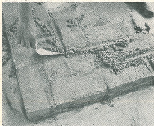
Bild 4. Överskottsbruk avlägsnas med en skårslev e. d. varefter tegelgolvet sopas rent från bruksrester.
