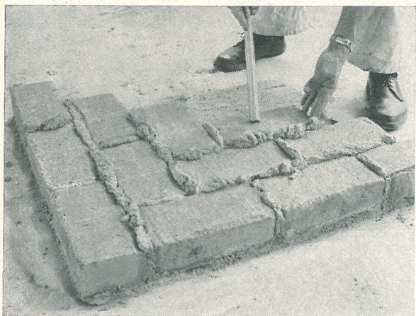
Bild 2. Om golvet ej skall maskinslipas lämnas de över fogarna bildade "brukskorvarna" orörda tills de har torkat så mycket att de inte längre kan smutsa ner tegelytan. Om golvet däremot skall maskinslipas spelar det ingen roll om det smutsas ner av bruk. Fogstrykningen kan då utföras innan bruket torkat.
