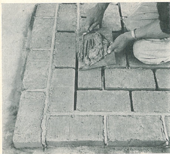
Bild 7. Fogarna stryks med fogslev av stål. Bruket tas från en fogplåt, dvs. en liten plåtbricka.
