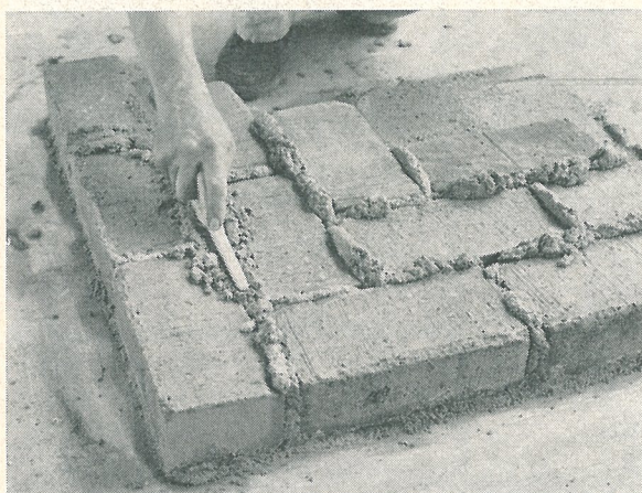
Bild 3. Fogstrykningen sker lämpligast med en fogslev av trä varmed bruket trycks ihop i fogen. Eventuella håligheter fylls med avskrapat bruk och stryks med fogslev.
