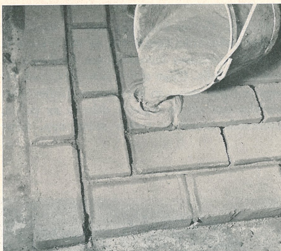
Bild 9. Bruk med vällingkonsistens hälls ut över golvytan.
