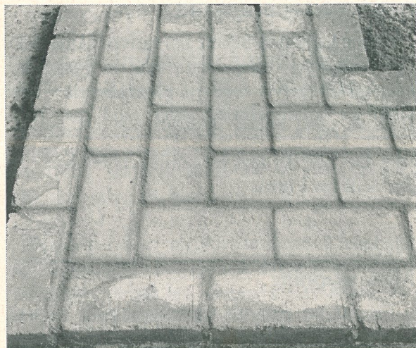
Bild 12. Om bruket sjunker i fogarna eller dessa inte blivit helt fyllda upprepas behandlingen. Brukslagret på golvet slipas bort vid den påföljande maskinslipningen.
