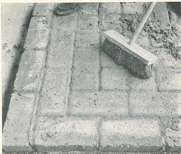
Bild 11. Man kan också använda piassavakvast för att sprida ut bruket. Även borstning bör utföras diagonalt över fogarna.
