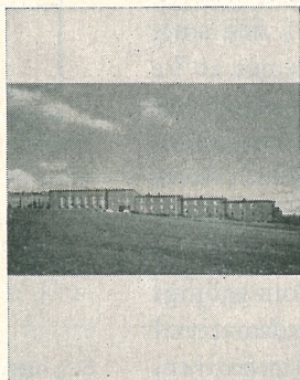
Omslagsbilden visar Östersunds Praktiska Realskola, ritad av arkitekterna C. Strehlenert och O. Elgquist. Foto: Gösta Nordin.
