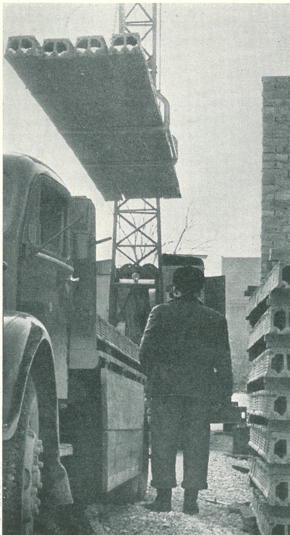
Tegelbjälklaget vid byggnadsingenjör Willy Wihlborgs radhusbebyggelse i kvarteret Gösen, Limhamn lades på några timmar med hjälp av den stora kranen som tegelleverantören höll med. Kranen kunde lyfta 4 balkar på en gång och direkt från lastbil lägga dem på plats. Tidsvinsten för byggmästaren blev över en månad.
