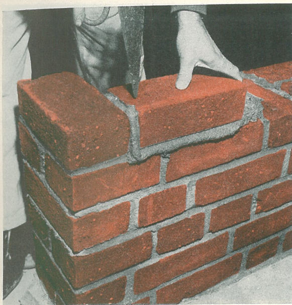
Då stenen lägges skall det finnas så mycket bruk att detta tränger ut. Observera att även stötfogen skall bli fylld direkt.
