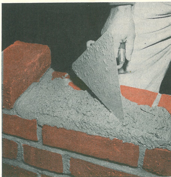
Liggfogsbruket skall bredas ut på muren så jämnt som möjligt och utan några djupa fåror. Bruket får inte bredas ut på så långa sträckor att vattnet hinna sugas bort i någon nämnvärd omfattning.
