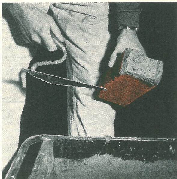
För att få stötfogen fylld med murbruk, är det nödvändigt att lägga på en full stötfog på en gång. Det räcker inte att bara slå på en "bruksklatt" eller "tugga" på ena hörnet.
